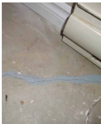
Figure 5 ↑ Obturation des fissures dans les murs de fondation et les planchers.
