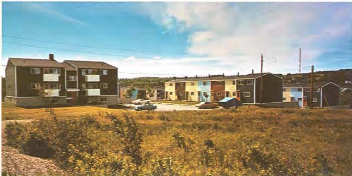
Ensemble fédéral-provincial d'habitations à loyer modique réalisé à Sydney, N.-E. Conçu par la SCHL.
