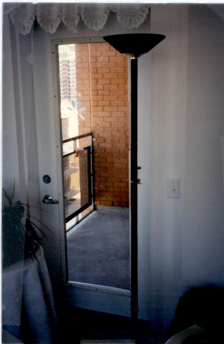
Figure 5.23 Les fenêtres ont été munies d'un mécanisme d'ouverture vers l'intérieur qui permet un maniement facile. Ces fenêtres ont cependant été critiquées par les résidents pour diverses raisons qui sont décrites à l'article 9.5.2.
