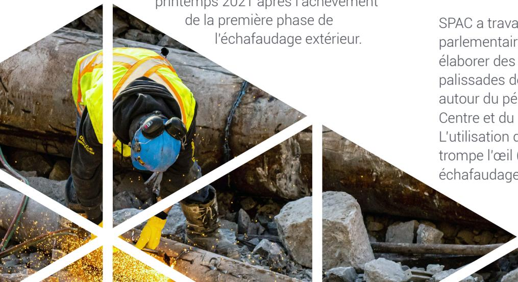
Un inventaire des pierres a été effectué et des maquettes patrimoniales ont été réalisées. En outre, le dégarnissage du mortier des joints de pierre et la réhabilitation des extrémités de poutres et des linteaux en acier de construction encastrés ont commencé.
