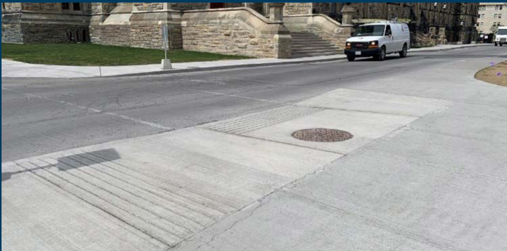
Coin sud-ouest de l'édifice de l'Est — après l'ajout de surfaces podotactiles et de marquages de passages pour piétons. — Services publics et Approvisionnement Canada
