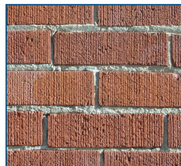
Mortier détérioré [2]
