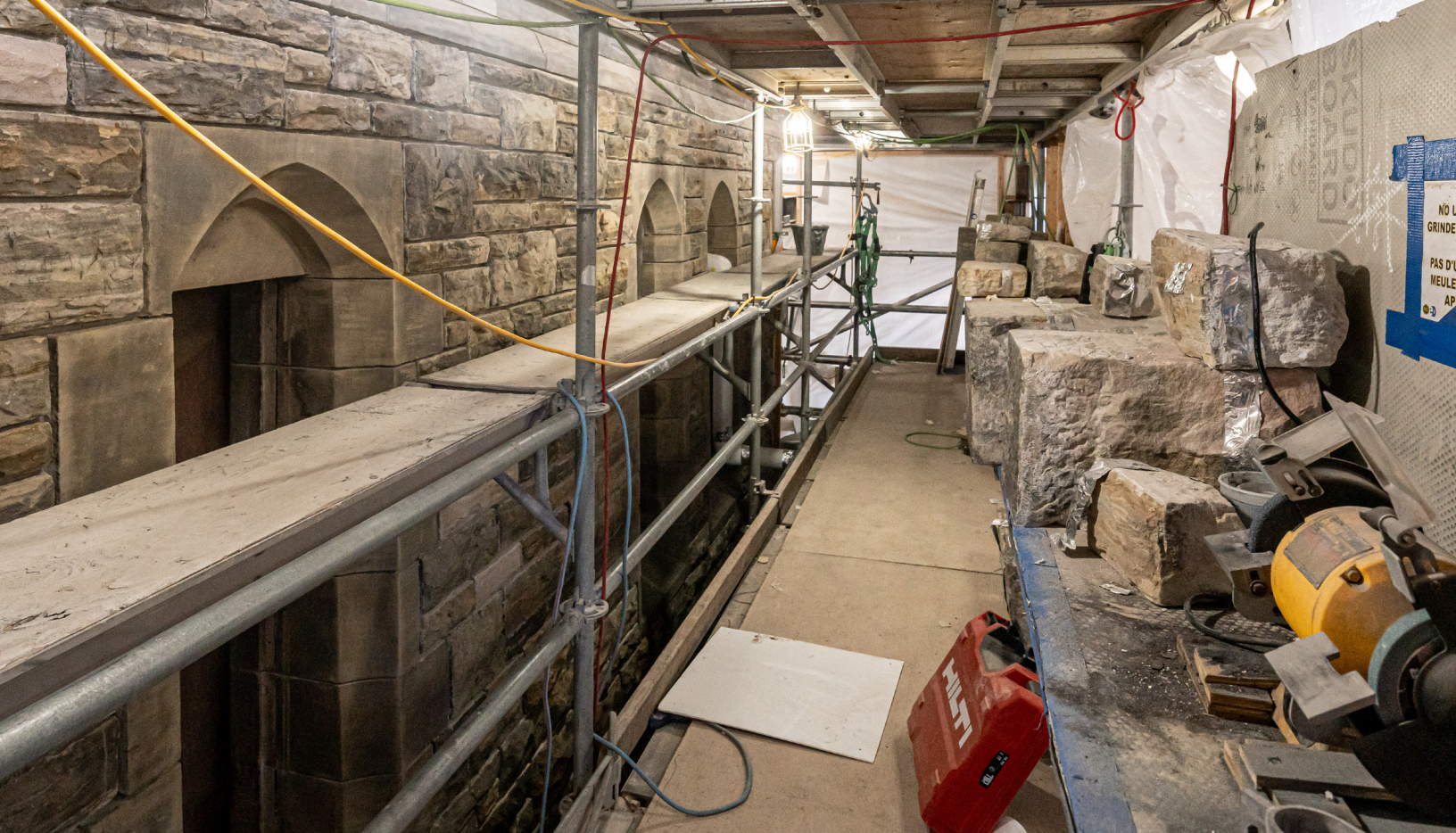
Figure 1 : Une photo des travaux de maçonnerie intérieurs effectués pour l'Édifce du Centre.
