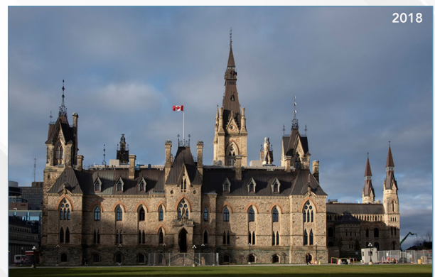
Figure 2 : L'élévation est de l'édifice de l'Ouest après la réhabilitation [1]
