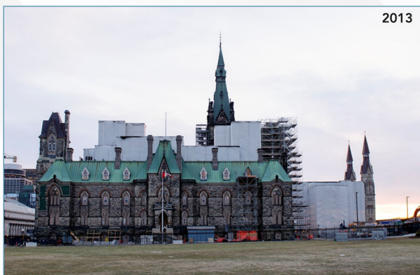
Figure 1 : L'élévation est de l'édifice de l'Ouest avant la réhabilitation [1]
