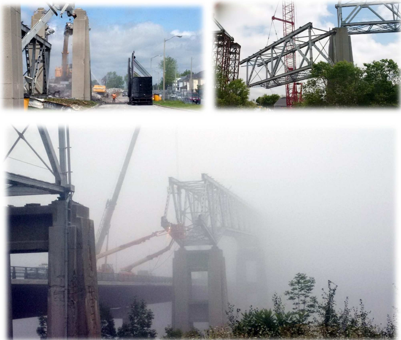
Démontage de l'ancien pont du chenal nord du pont international de la Voie maritime à Cornwall
