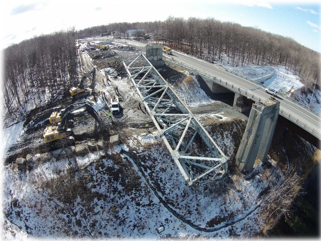
Vue du démantèlement de la toute dernière structure d'acier du vieux pont du chenal nord au pont international de la voie maritime à Cornwall.
