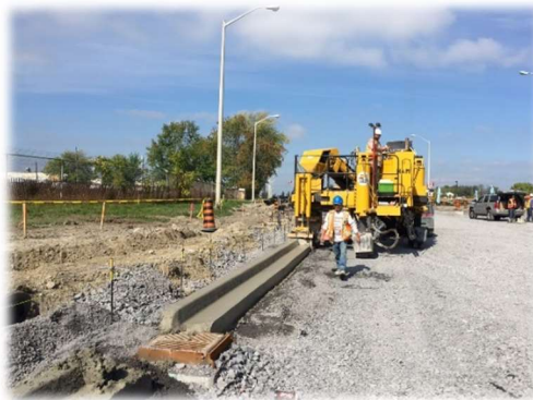
L'installation d'égouts sur l'avenue Brookdale à Cornwall
