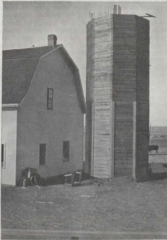
Le silo coffre, sans toit ni descente.
