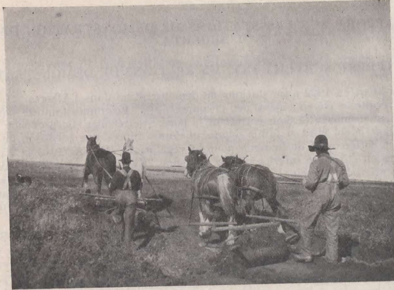
Excavation d'un silo-fosse à Delacour.
