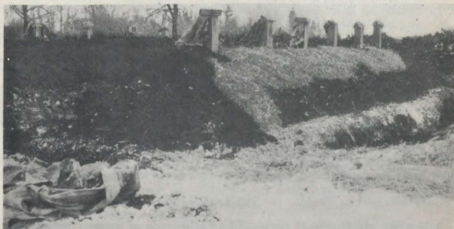
Mise de la deuxième (dernière) couverture de paille et de terre. On attend pour mettre cette dernière couverture que la première couche de terre soit bien gelée. Les ventilateurs sont recouverts de sacs pour contrôler la température.
