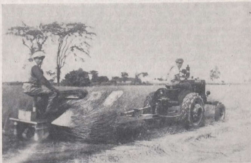
Arrachage du lin à la station de démonstration de l'Acadie au moyen d'une arracheuse moderne fabriquée au Canada.
