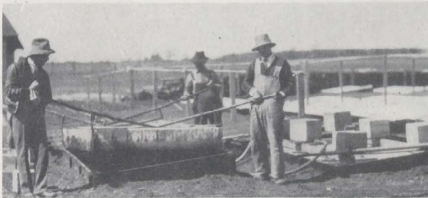
Stérilisation des couches de tabac à la vapeur au moyen de la méthode du bassin renversé
