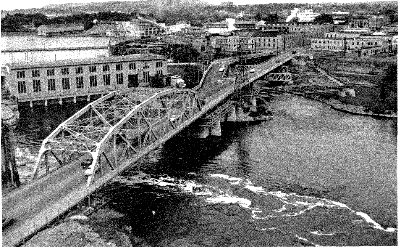
Améliorations aux approches du pont des Chaudières sur la rivière Ottawa. La voie de droite de la section du chemin multiple se trouve sur la nouvelle travée d'acier.
