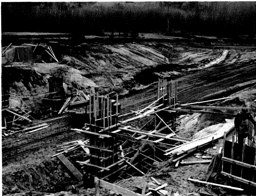
Passage supérieur de Kingsmere en construction.
