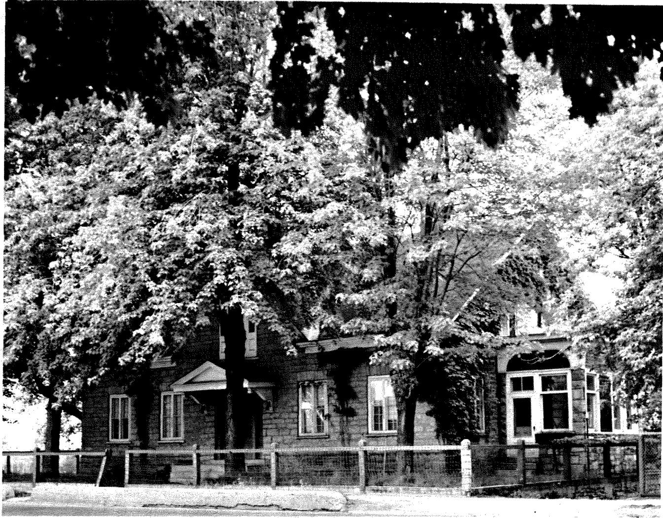
La maison de BRIGHAM à Hull -- Construite en 1834 par Thomas Brigham, chef de fabrique influent et le premier à faire venir le courrier à Hull, cette maison d'architecture de la période georgienne au Canada a été rénovée par la CCN.
