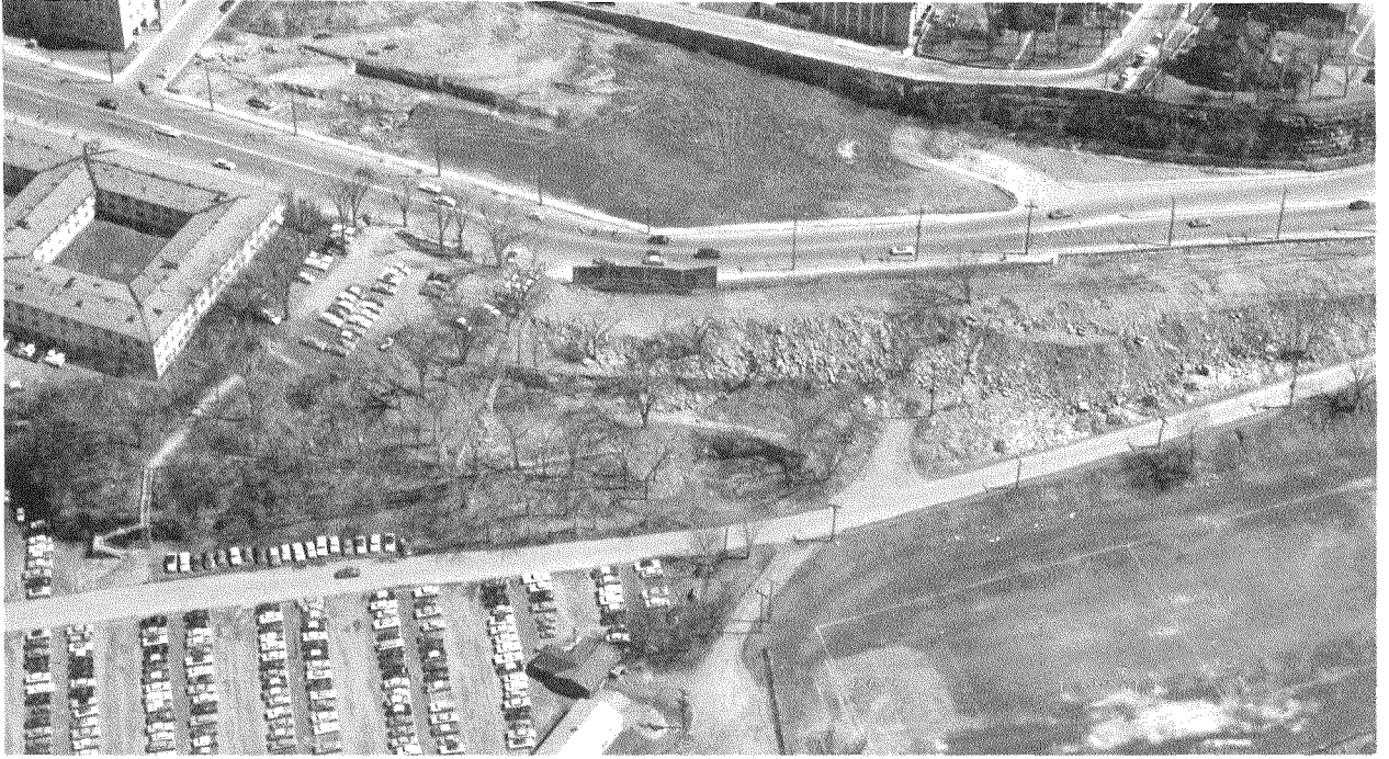
Jardin des Provinces en construction.
