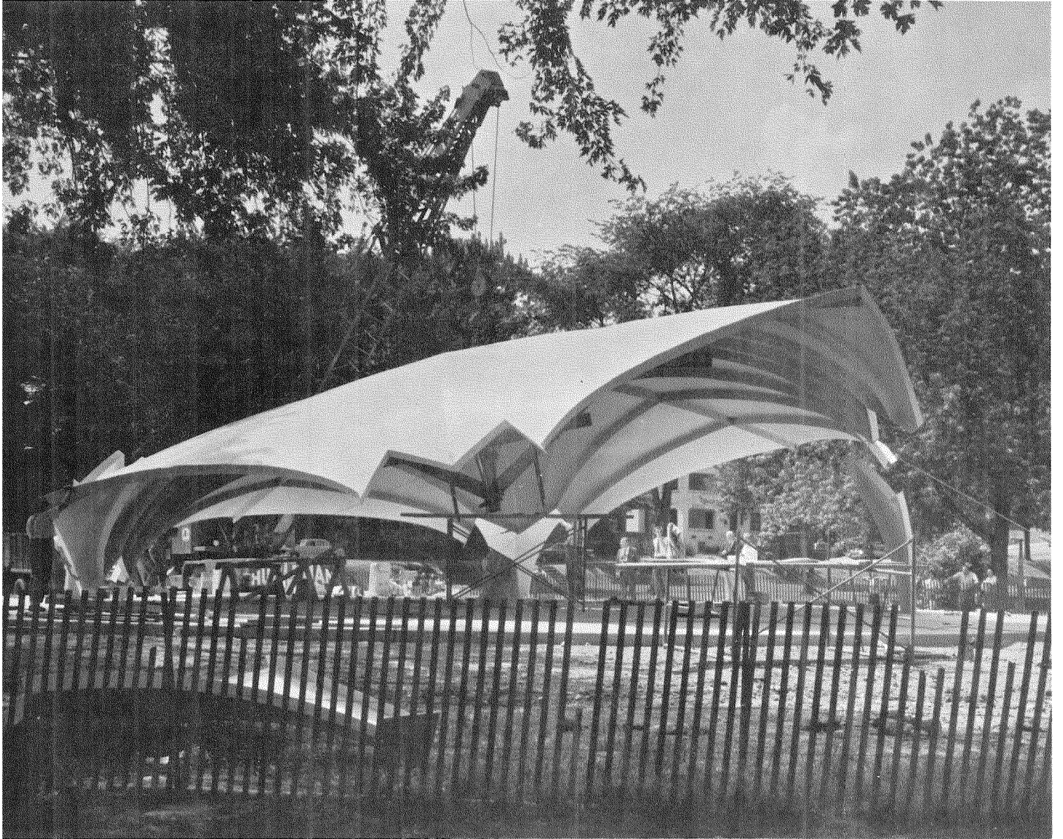
Installation d'un nouveau pavillon en matière plastique au parc Strathcona, dans la Côte de Sable à Ottawa.
