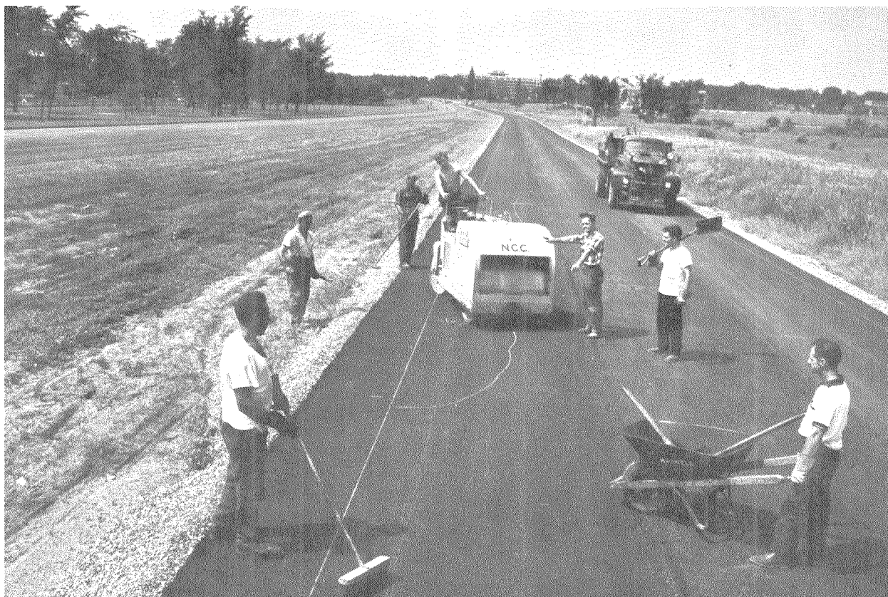
Seconde voie de la promenade de l'est que des hommes de la CCN sont en train d'achever.
