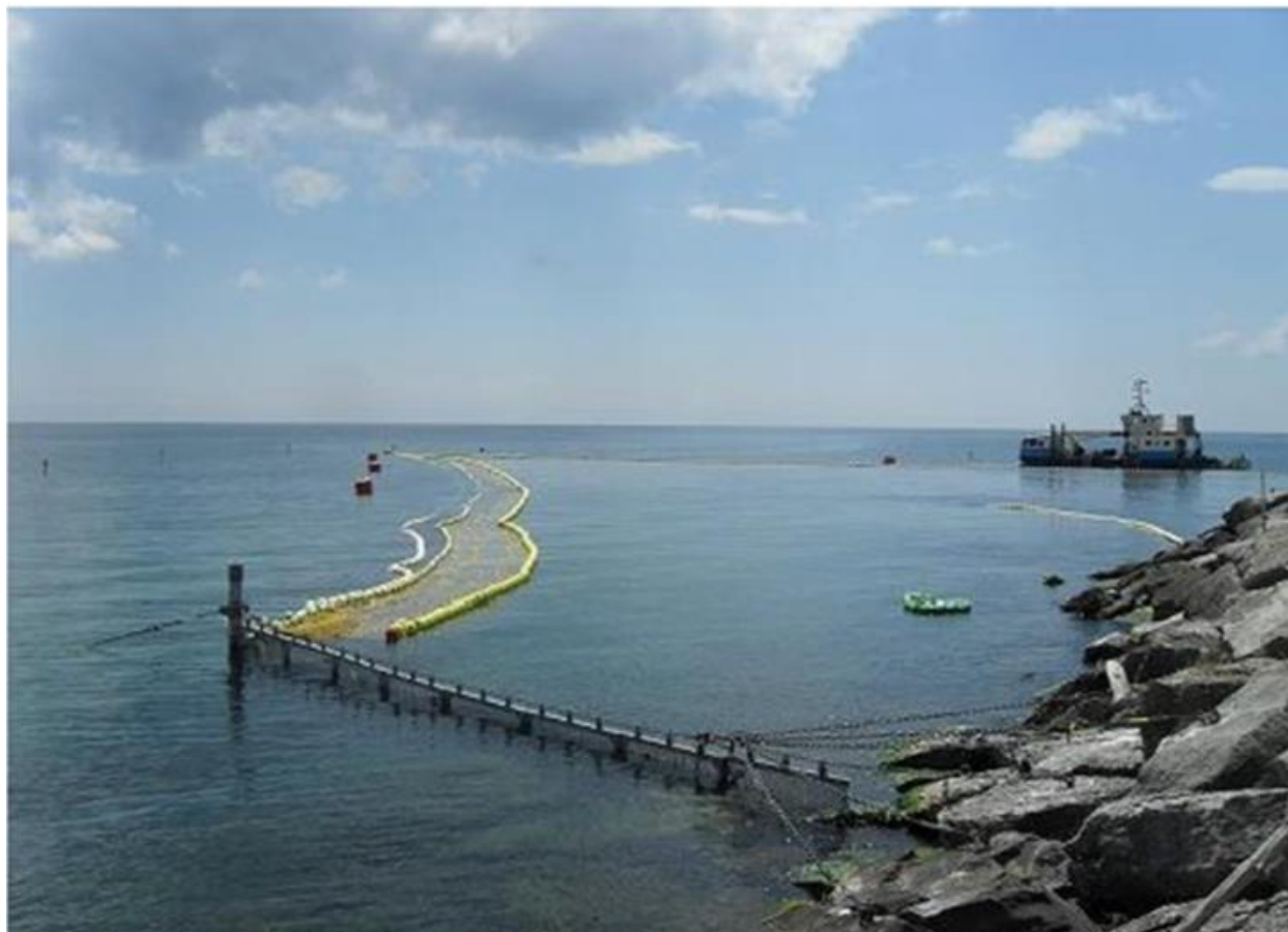
Figure 2.2 : Système de déviation du poisson d'Ontario Power Generation : une structure d'atténuation visant à réduire la biomasse associée à l'impaction du poisson [10]
