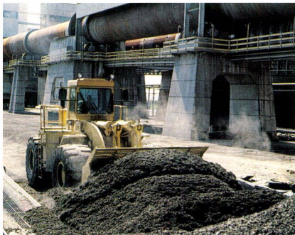
La combustion de pneus déchiquetés comme source d'énergie à la cimenterie Lafarge Canada.
