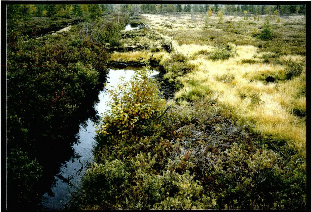
**Photo 9:** Vue générale des aménagements. Du premier plan vers l'horizon, on remarque la mare 1, le filtre alcalin et la mare 2 au temps 2.
