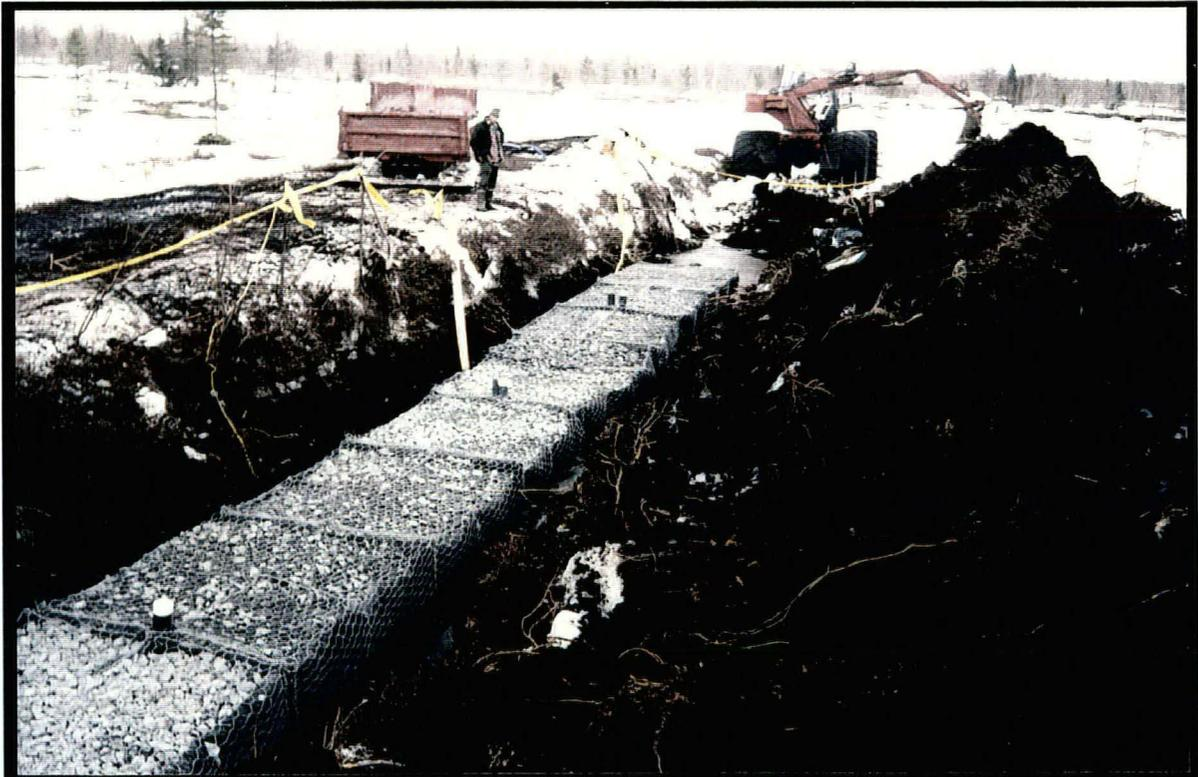
**Photo 4:** Le filtre alcalin avec ses puits d'échantillonnage lors des travaux d'aménagement.
