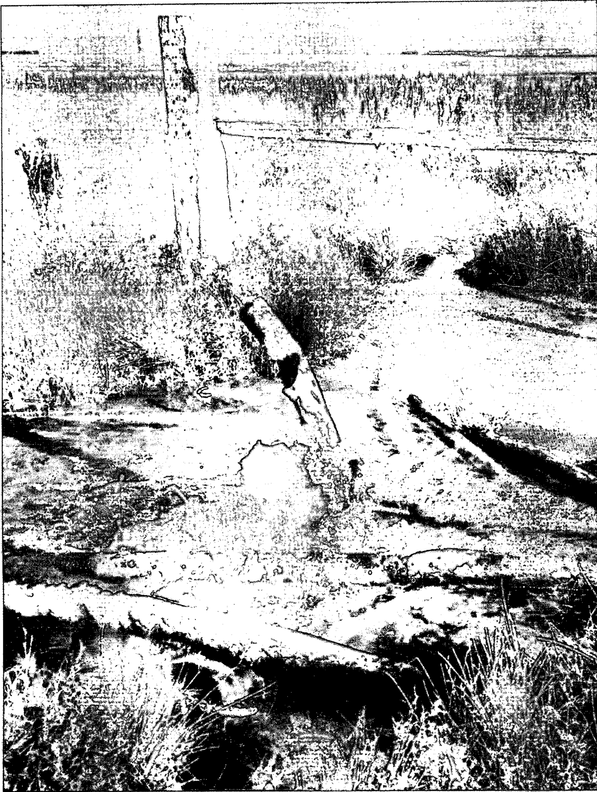
Puits de ferme abandonné près de Nokomis en Saskatchewan. L'eau ferreuse s'écoule d'un aquifère situé dans les entrailles de la terre. Lorsque l'eau entre en contact avec l'air, le fer se précipite, laissant des dépôts oranges sur les bûches et les rochers.
