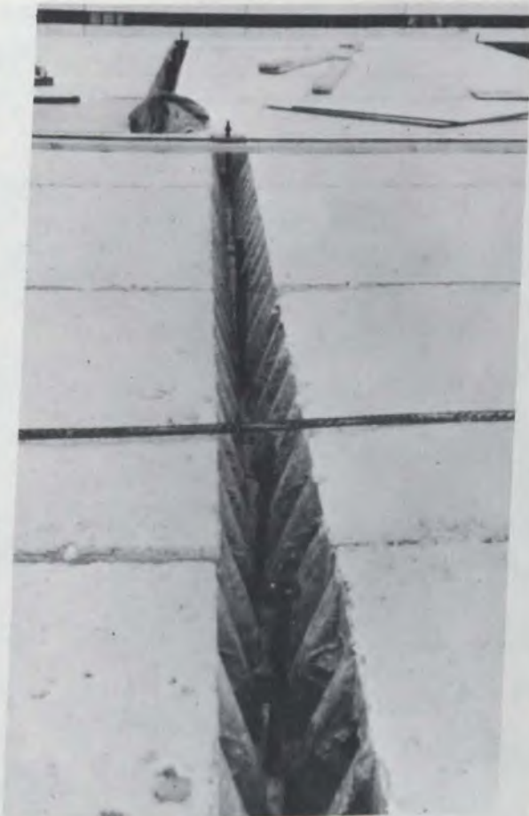
Collectif près de Malmö - Dalles-planchers en place
