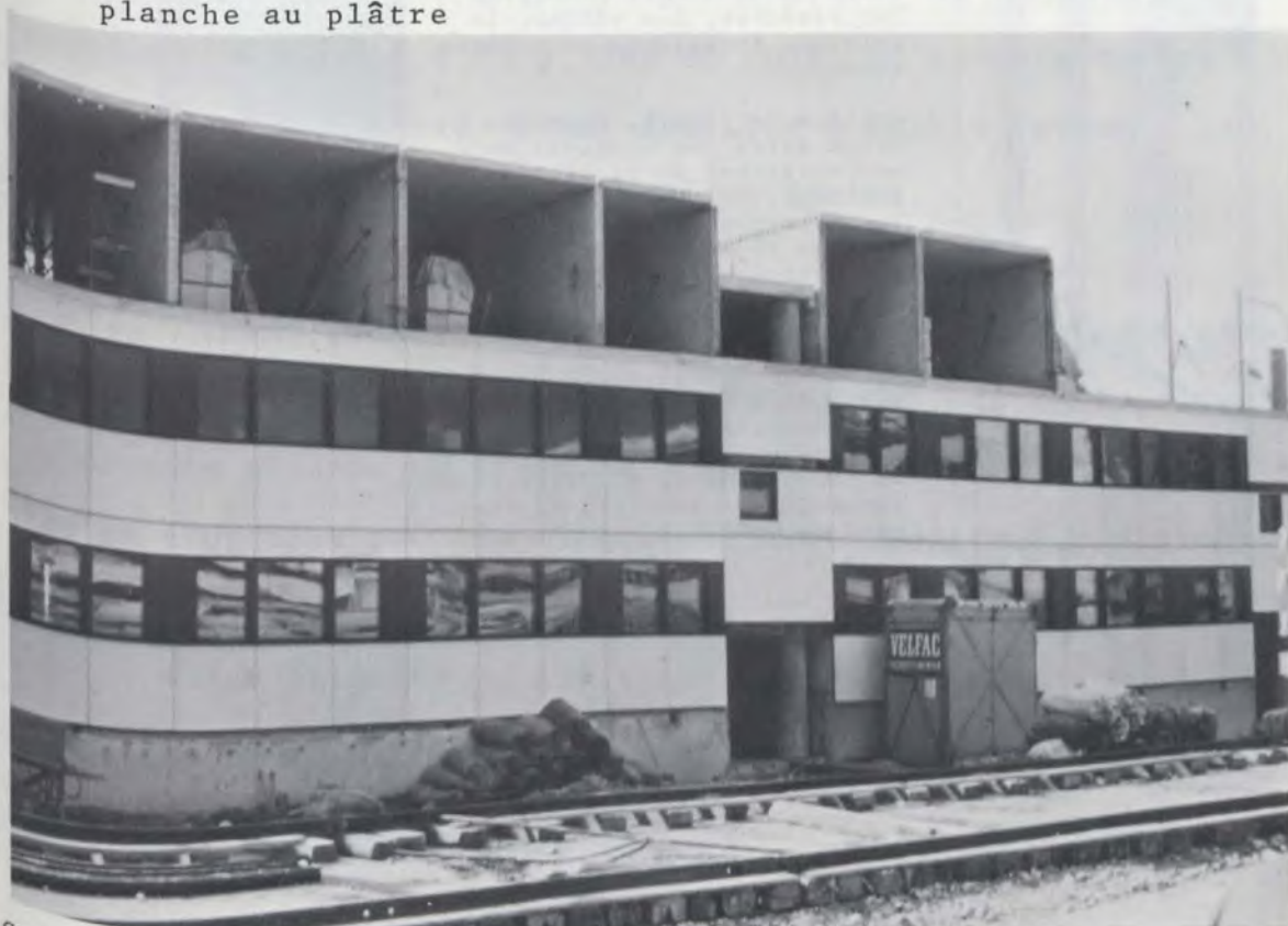
Collectif en construction. Les matériaux de finition intérieure sont stockés à l'intérieur avant le montage des façades.
