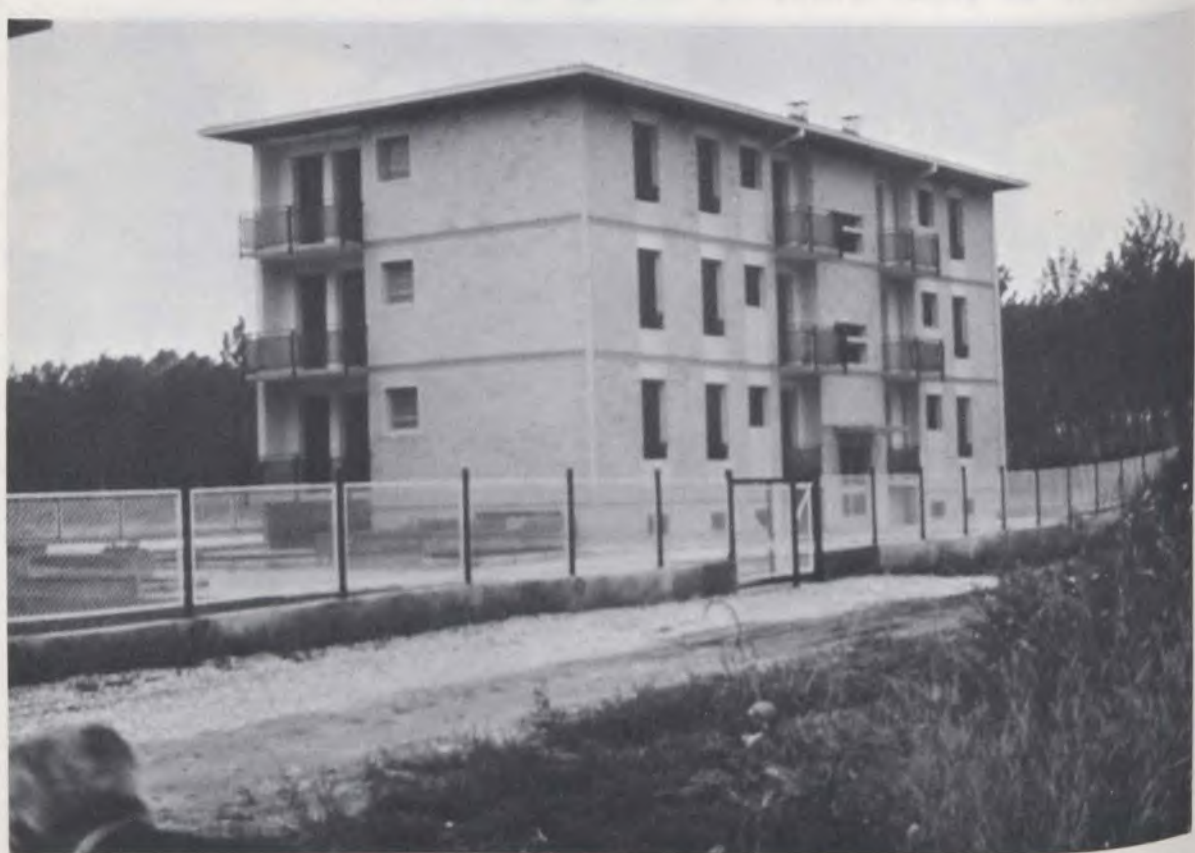
Bâtiment expérimental en panneaux de brique précoulés en usine
