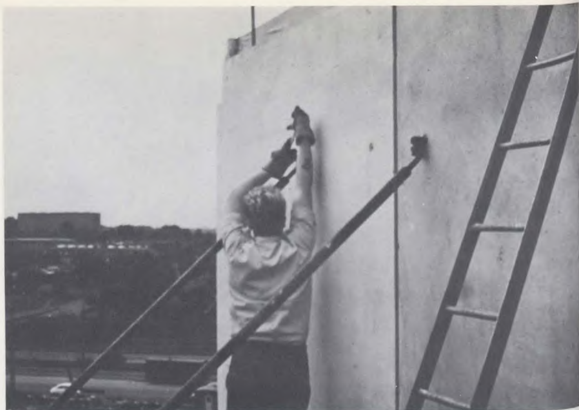
Fixation d'un panneau-façade
