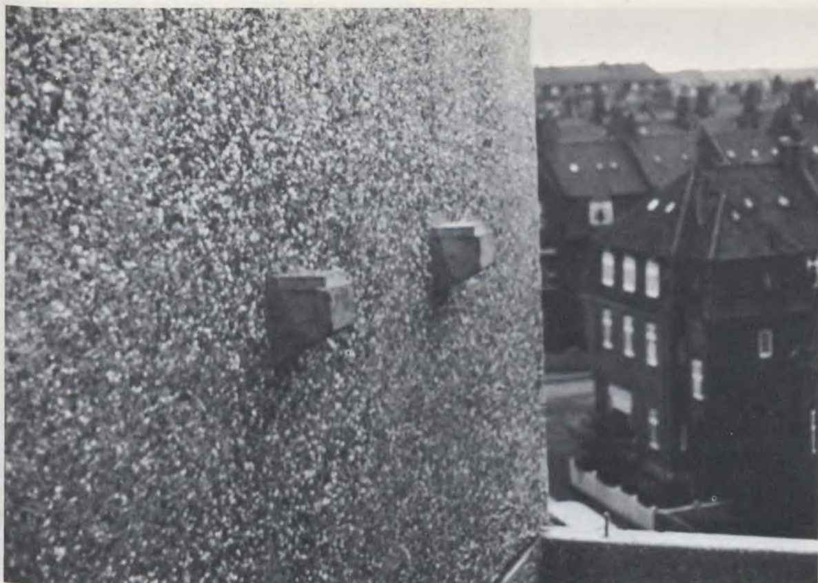
Panneau-mur de cage d'escalier avec appuis de palier
