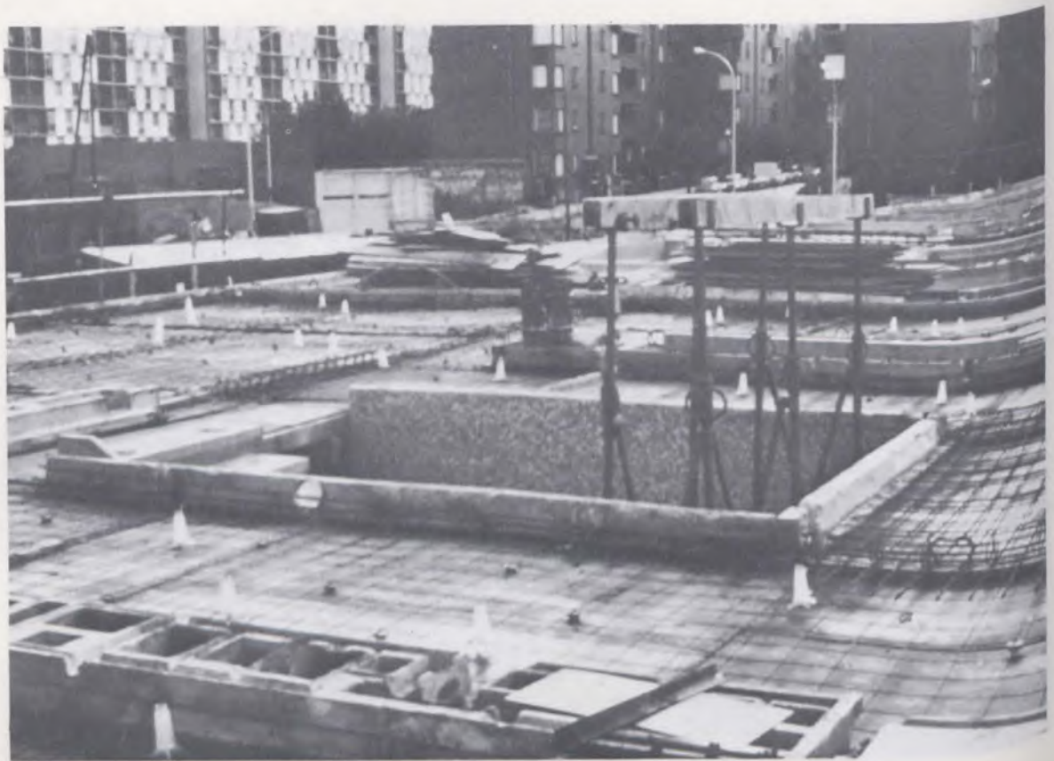
Planchers coulés en place sur coffrage-outil
