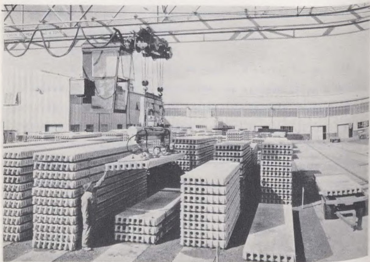
Aire de stockage d'usine
