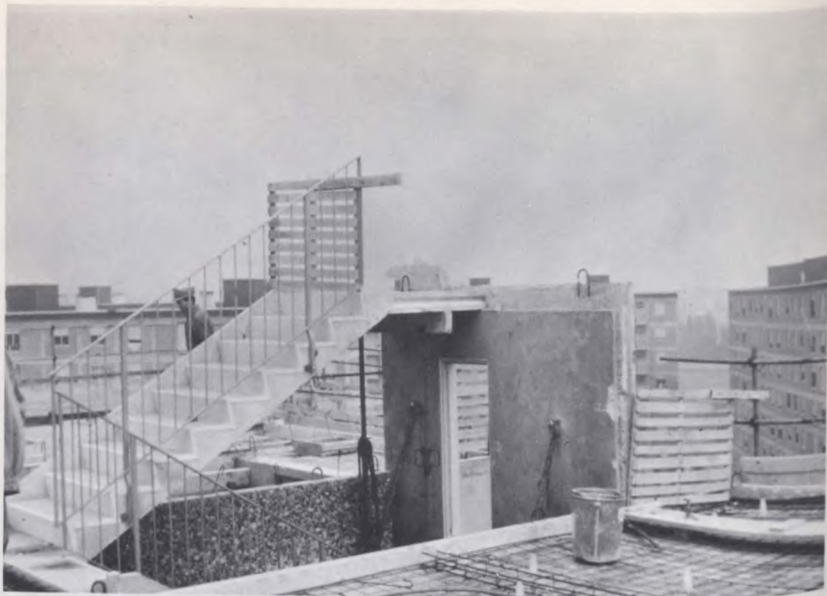
Installation des escaliers
