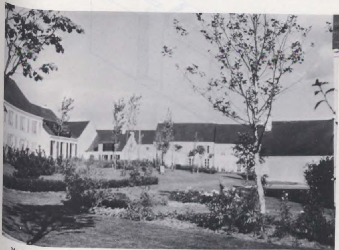
Maisons unifamiliales et maisons de rangée à Grand-Village
