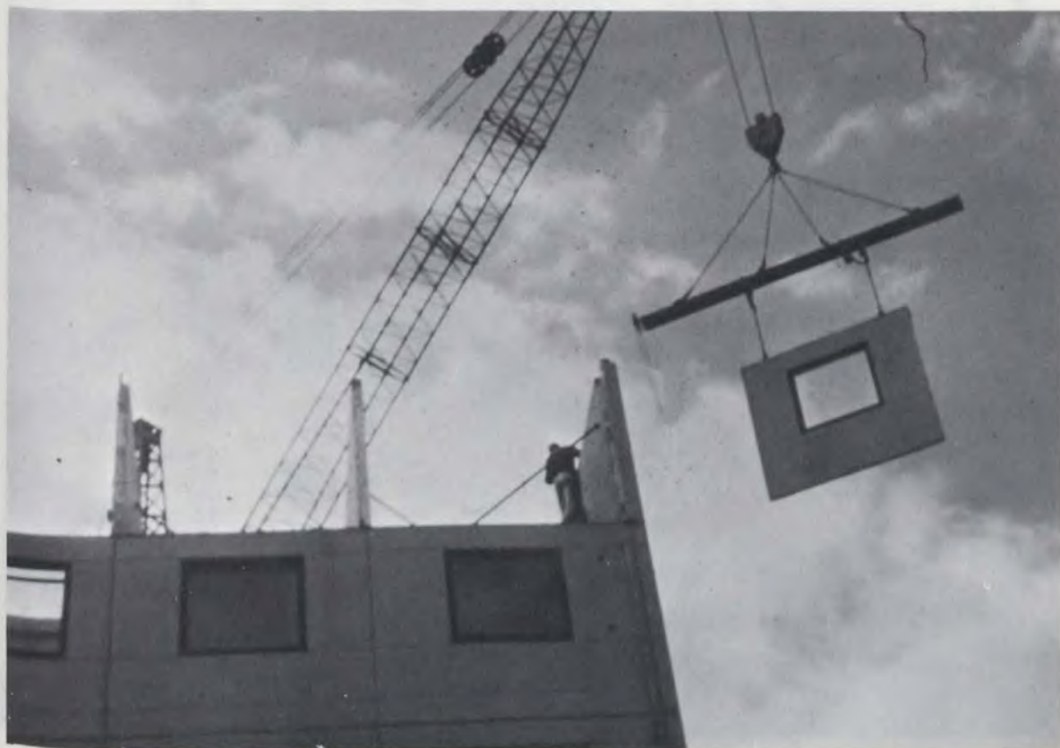
Mise en place d'un panneau-façade
