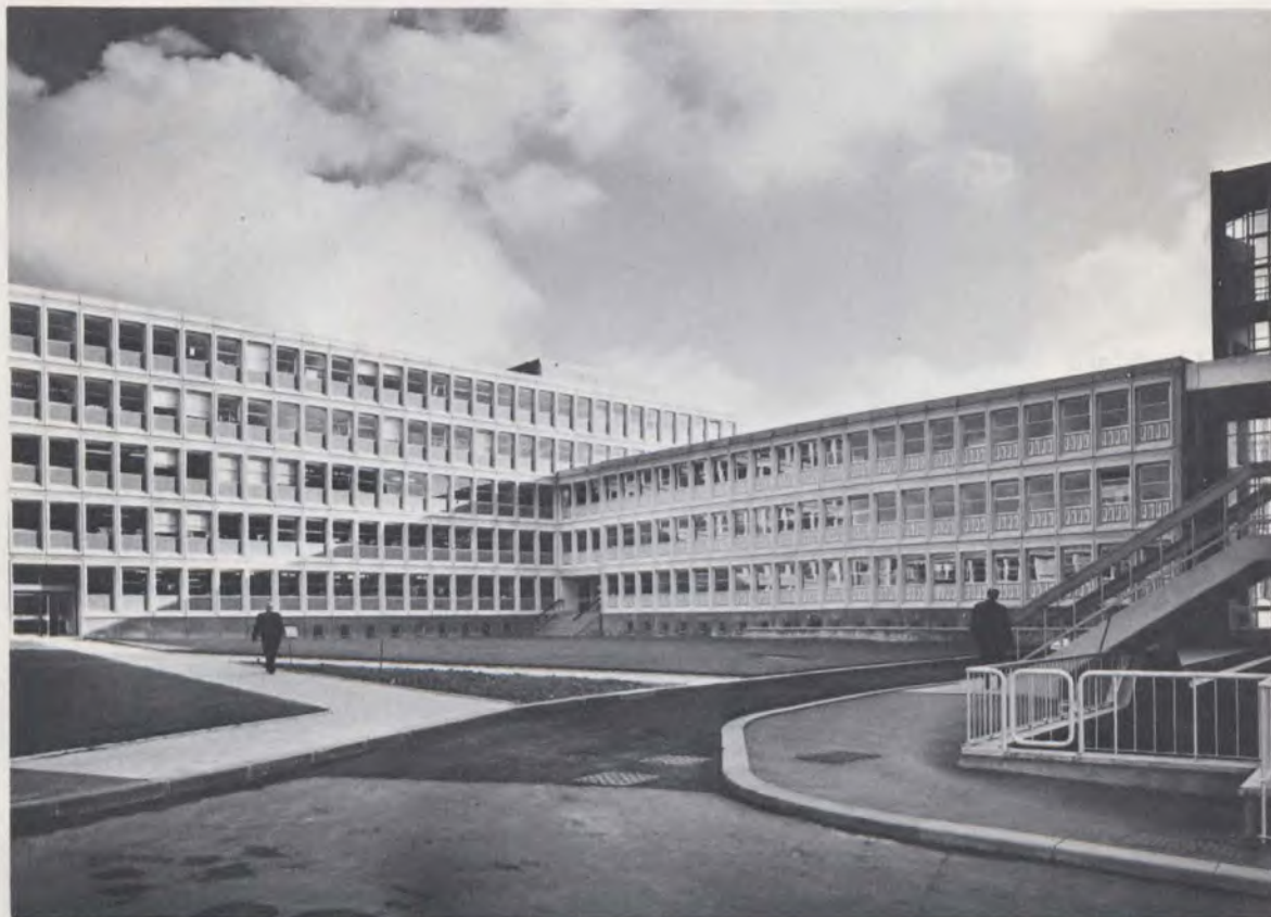
Siège de la John Laing and Son Limited à Mill Hill, Londres, N.W.7, réalisé par le procédé Laingwall de construction industrialisée
