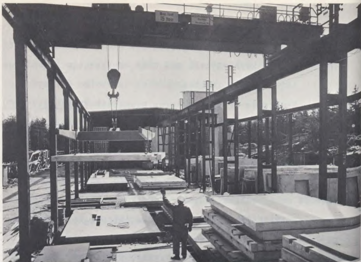
Usine du chantier de Bollmora, 1961-1963. 500 appartements.
