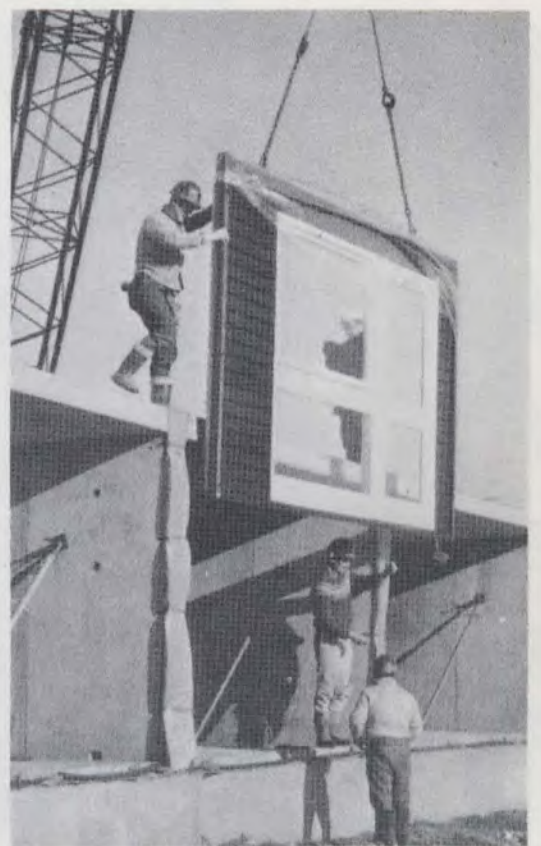
Mise en place des panneaux-murs
