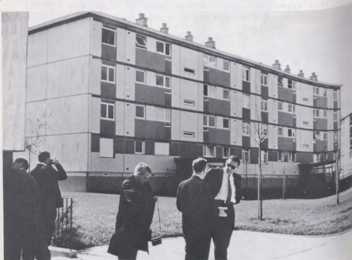
Appartements à loyer moyen près de Paris. Revêtement en travertin et en ardoise.
