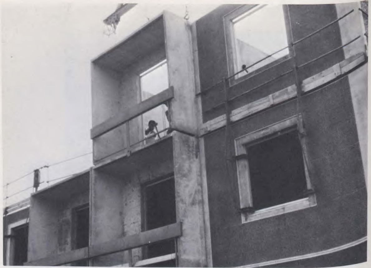
Installation d'un balcon
