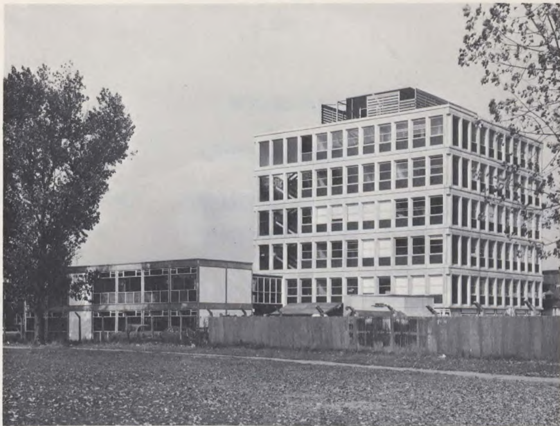
Immeuble à bureaux de six étages construit par le procédé Laingwall à Boreham Wood, Hertfordshire, pour la division de recherche et de développement de la John Laing Construction Limited
