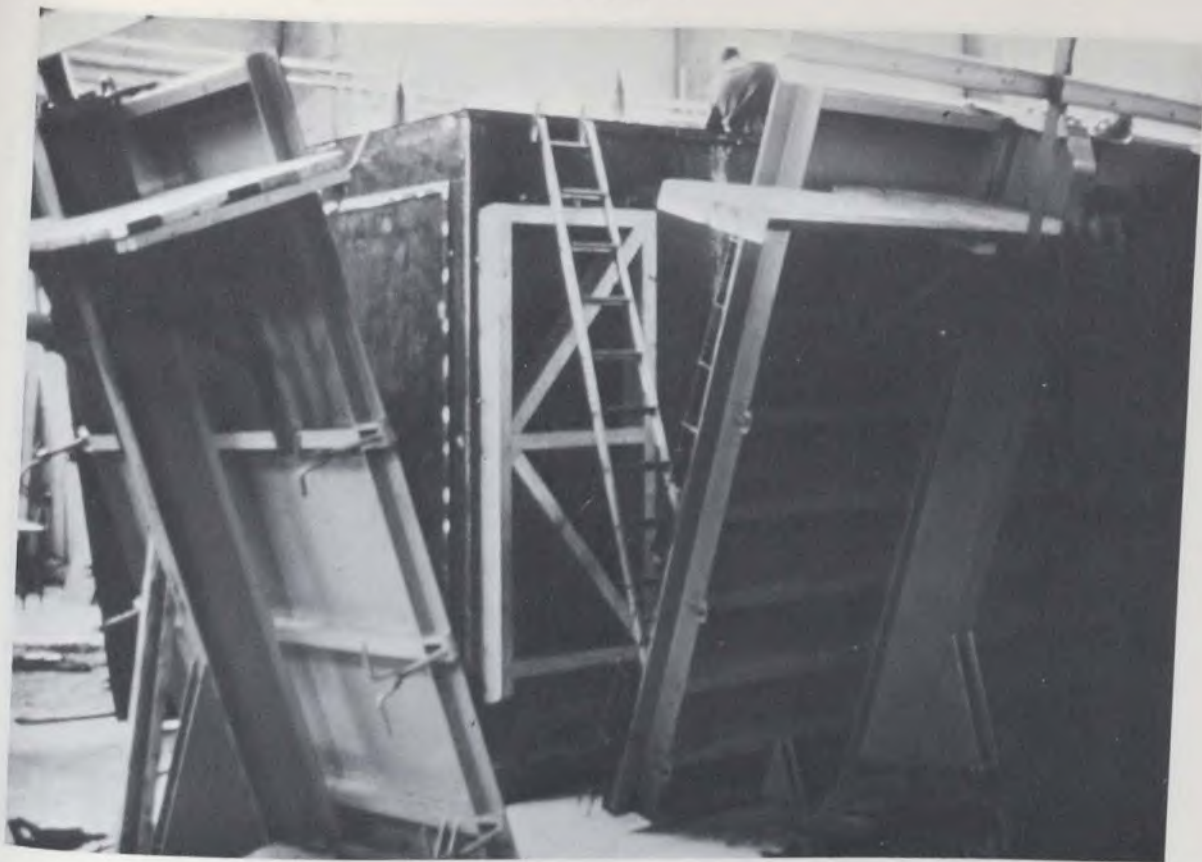
Montage de moule de précoilage.
