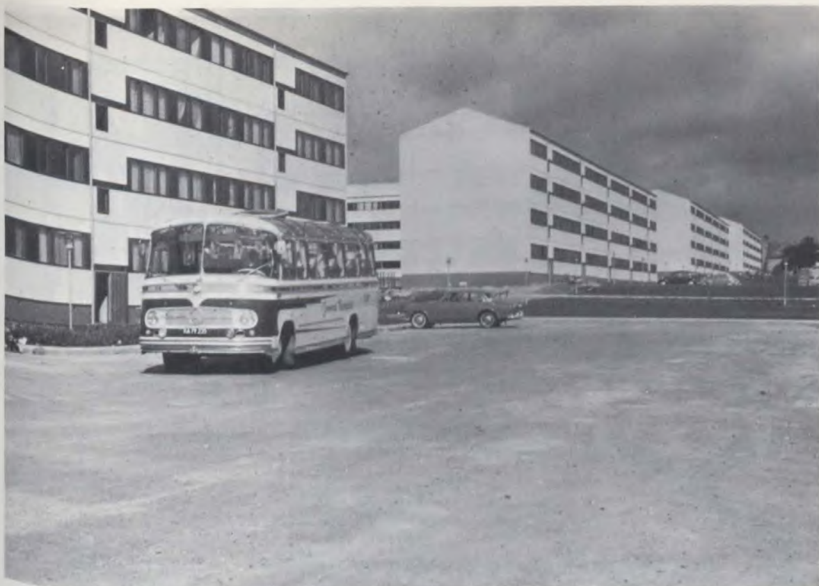
Chantier près de Copenhague - Panneaux-façade à pans de bois, fenêtres coulissantes, revêtement extérieur en feuilles de fibro-ciment, revêtement intérieur en planche au plâtre
