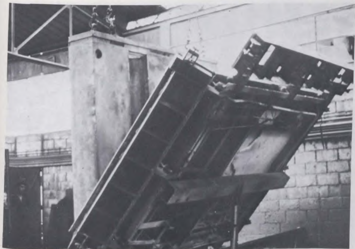
Décoffrage d'une unité fonctionnelle
