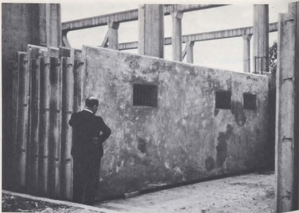
Grands panneaux de sous-sol
