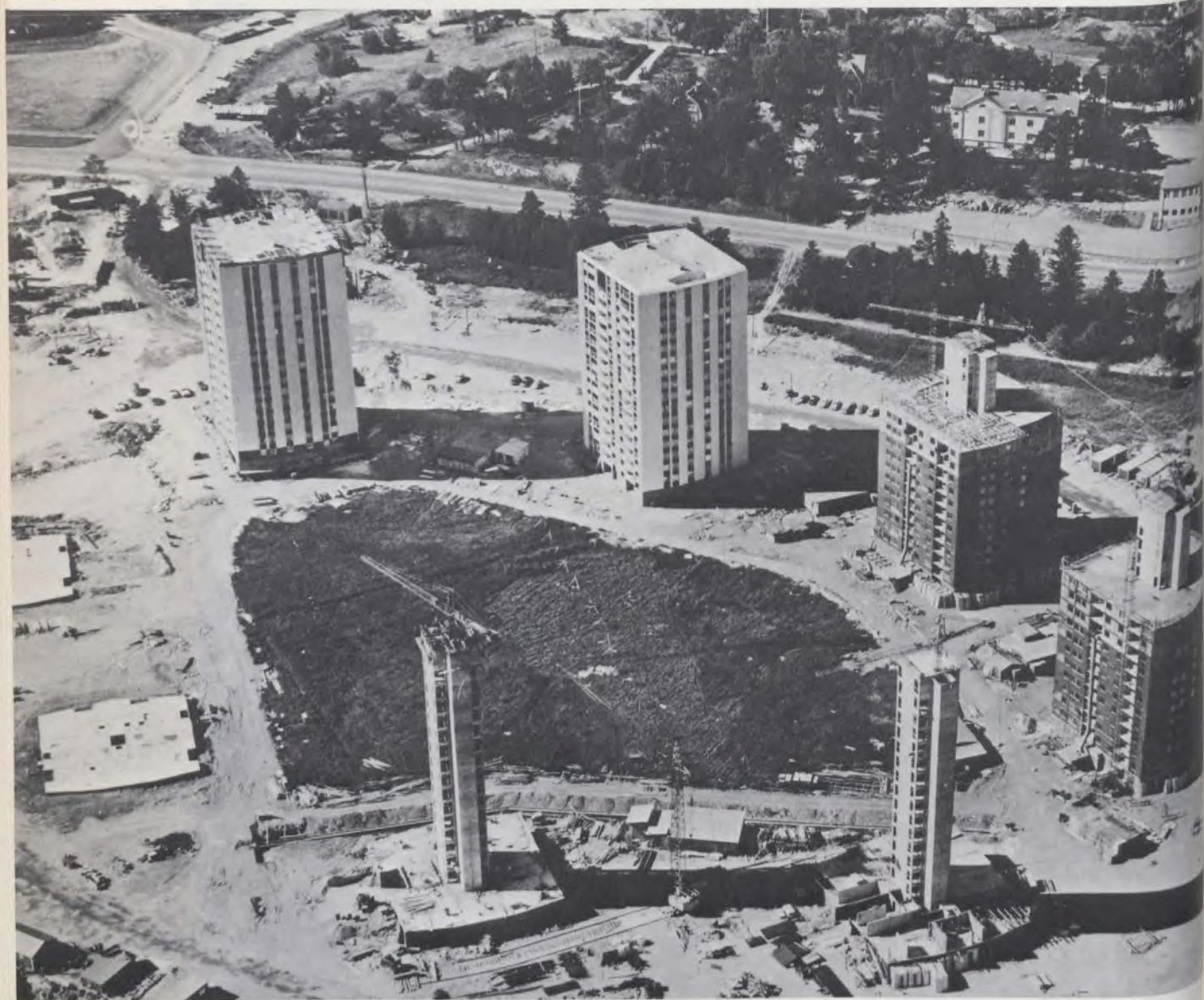
Nåsbydal, 1959 - Procédé Sharne léger: immeubles de 8 - 17 étages en construction
