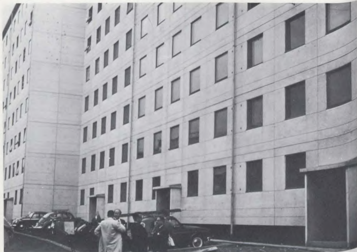
Collectif en construction à Copenhague
