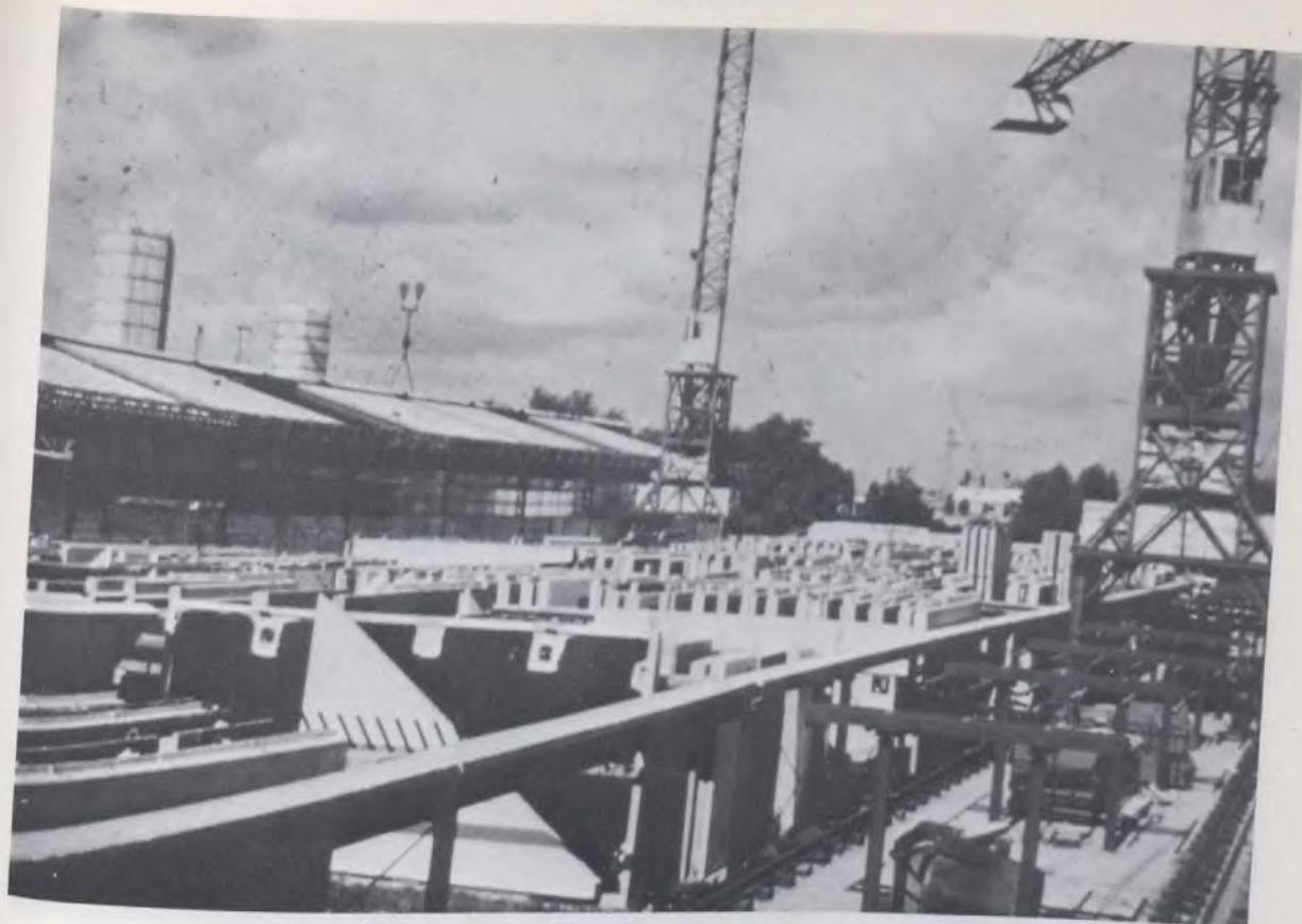
Usine de Villeneuve-le-Roi
