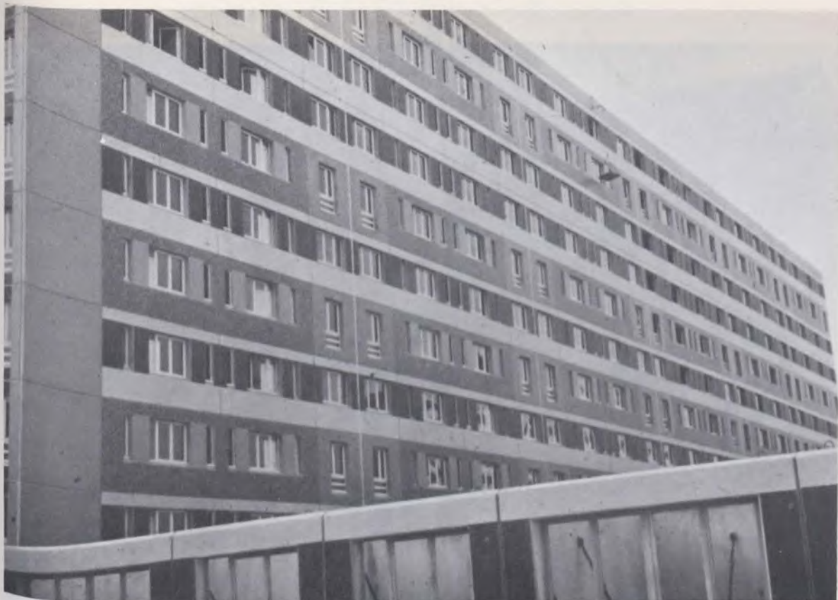
Appartements à loyer modique en construction près de Paris
