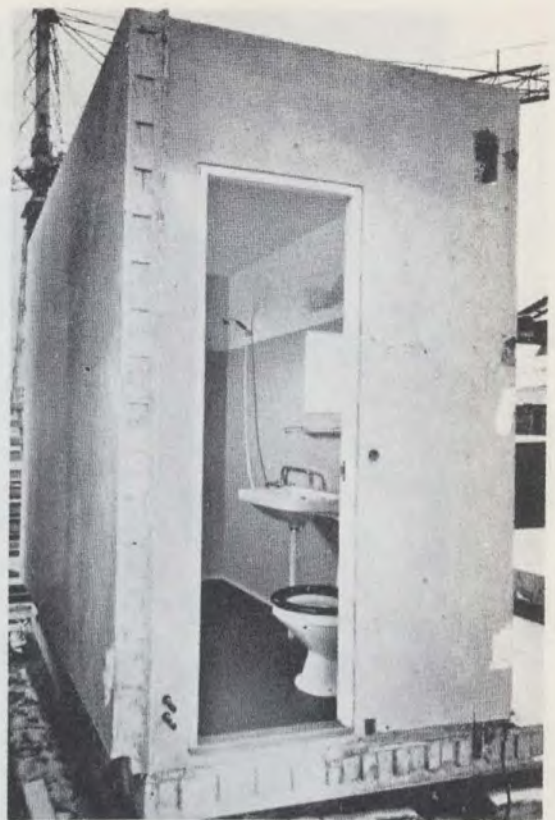
Bloc-bain complet entièrement réalisé en usine. La porte est posée et reste verrouillée pendant le transport et les travaux de construction au chantier.
