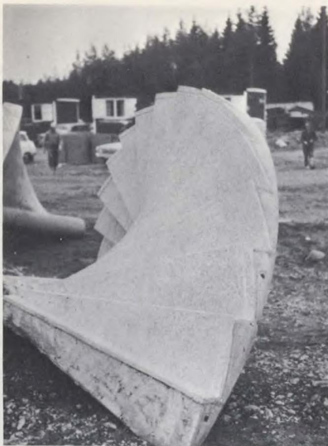
Escalier circulaire préfabriqué
