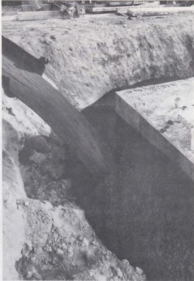
Figure 6 : Remblayage à masse spécifique contrôlée pendant la construction de fondations.
