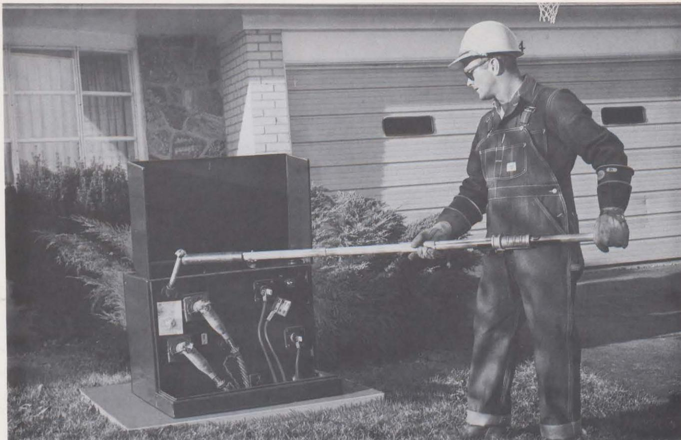
*La distribution souterraine aux quartiers résidentiels emploie des transformateurs et les commutateurs connexes montés sur des galets de béton.*
