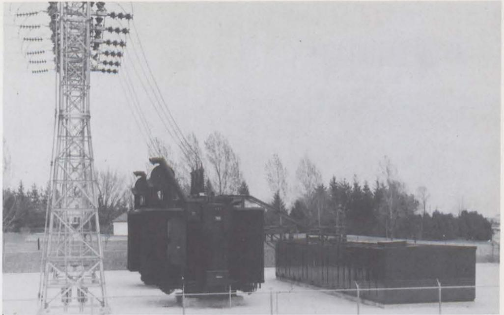
*Sous-station typique de distribution: structure, transformateur et appareillage de commutation à l'extérieur.*
