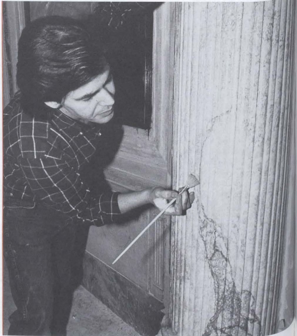
Le gouvernement fédéral a affecté 5 millions de dollars à la rénovation du complexe abritant les Théâtres Elgin et Winter Garden. Le conseiller en restauration, David Hannivan, marbre l'une des colonnes du foyer. (Photo : gracieuseté du Elgin and Winter Garden Project)
