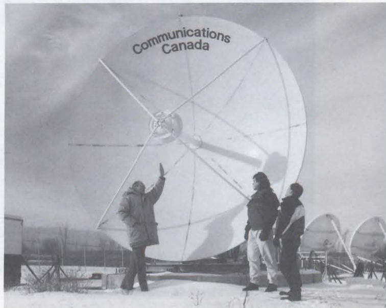
Une antenne parabolique de 4,2 mètres ayant servi aux expériences du programme Olympus.
