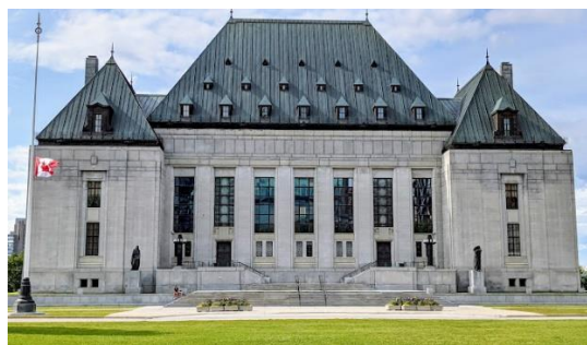
Édifice de la Cour suprême du Canada à Ottawa, Ontario.
