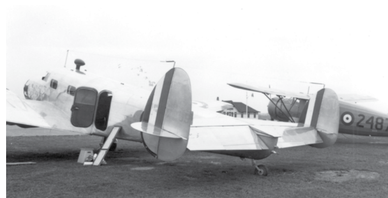
Le seul modèle 212 de l'ARC qui figure dans cette photo était pratiquement identique au modèle 12 de Lockheed, l'Electra Junior, qui fut produit en plus grand nombre et qui était également utilisé par l'ARC. Un Norseman est visible à l'arrière-plan. (Photo : Bibliothèque et Archives Canada, PA64052)
