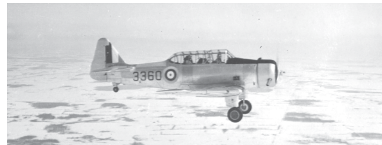
Ce Yale en vol, exploité par la 31 e École de pilotage militaire de Kingston, montre bien le train d'atterrissage fixe de l'appareil qui permet de distinguer ce type de son successeur, le Harvard. (Photo : M. Stanley Leversedge)
