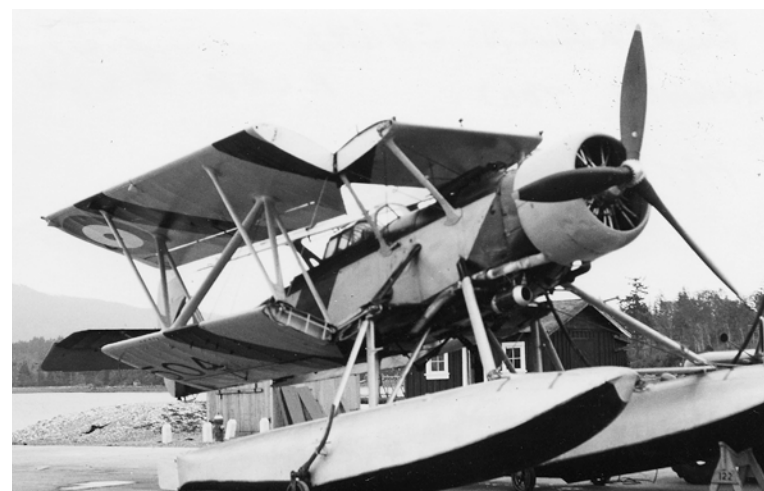
Après la guerre, les Blackburn Shark ont servi au remorquage de cibles et étaient alors peints selon un schéma de couleurs noir et jaune rayé distinctif. La photo ci-jointe démontre bien le mécanisme de repliage d'aile, en l'occurrence sur un Shark Mk III (construit par Boeing Canada) de l'ARC portant le suffixe 504, situé à Patricia Bay. (Photo : ARC)
