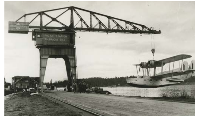
Étant un simple hydravion à coque, le Stranraer devait être sorti de l'eau à l'aide d'une grue ou d'un appareil de halage à terre. Cette grue à portique pour charges lourdes faisait partie de l'installation de l'ARC à Patricia Bay, en Colombie-Britannique. (Photo : ARC, CY22-7-GL)
