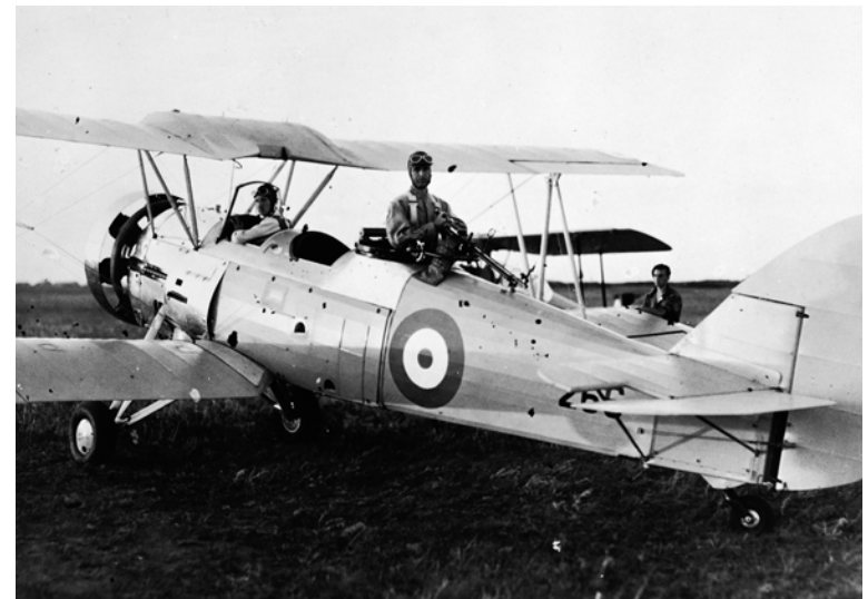
Avion-école Avro 626 portant le suffixe du 112 e Escadron de coopération avec l'Armée, avant son départ pour un exercice pour la mission. L'observateur ou tireur tient une mitrailleuse mobile Lewis. (Photo : ARC, PMR76-588)
