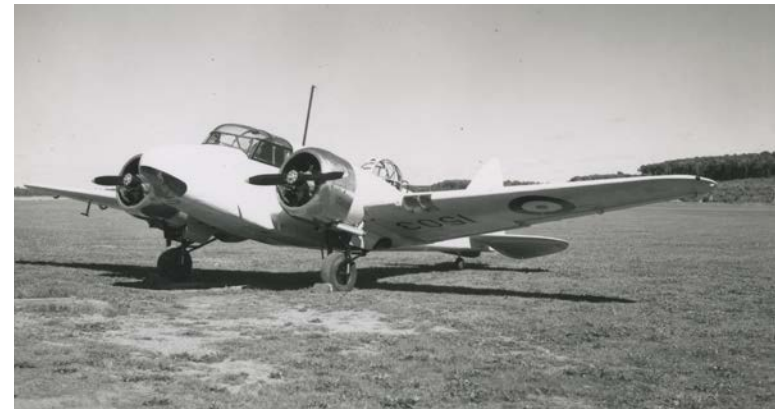
Un Airspeed Oxford Mk I portant le suffixe 1503, équipé pour l'entraînement au tir aérien. Remarquez la tourelle sur la partie arrière du fuselage. (Photo : ARC, HC-8704)
