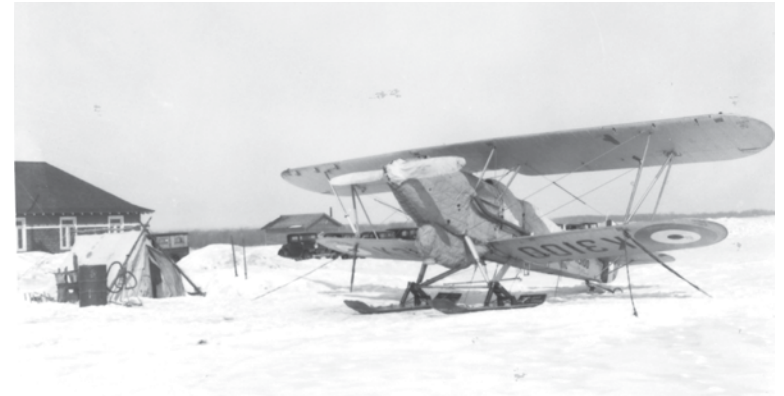
Vue hivernale d'un Audax de Hawker aux lignes aérodynamiques monté sur skis montrant le long tuyau d'échappement et le crochet de ramassage sous le fuselage. (Photo : Bibliothèque et Archives Canada, PA62981)
