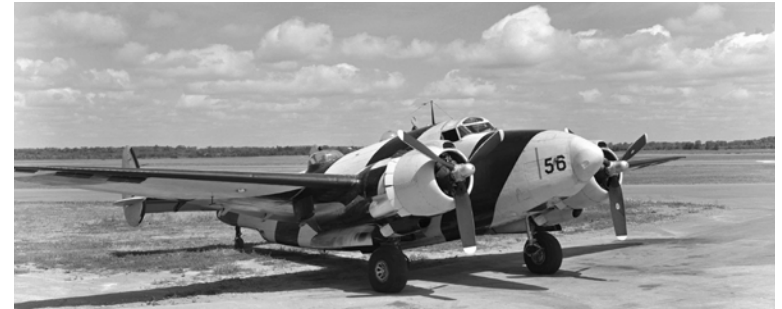
Ce dernier modèle G.R. MkV Ventura a été transformé en avion remorqueur de cibles, ce qui explique le schéma de peinture à rayures diagonales jaunes et noires. (Photo : ARC, PL-135257)
