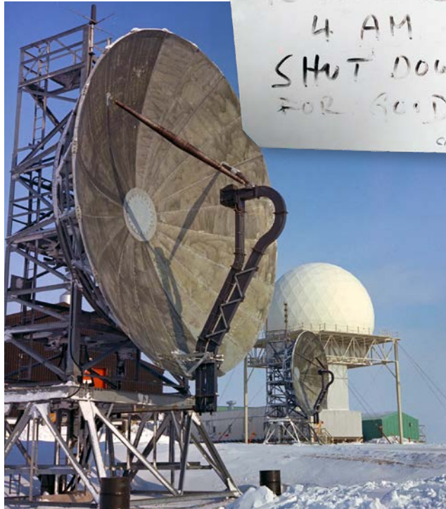
Gros plan de l'antenne radar et du dôme du site principal du réseau DEW situé à Cambridge Bay dans l'Arctique.
