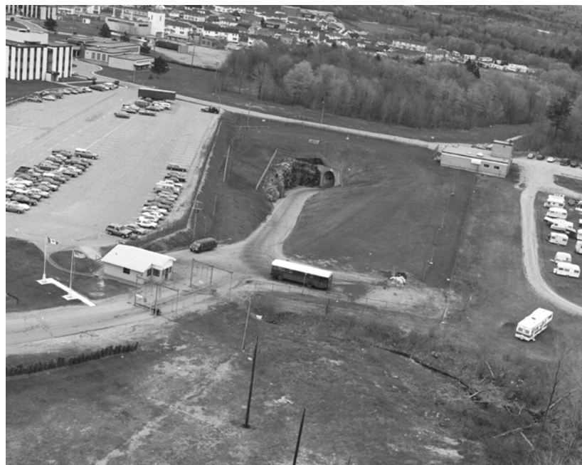
Vue aérienne de l'entrée du portail nord du complexe souterrain et du centre régional de contrôle des opérations. Le champignon de granit se trouve dans le hall du complexe.
