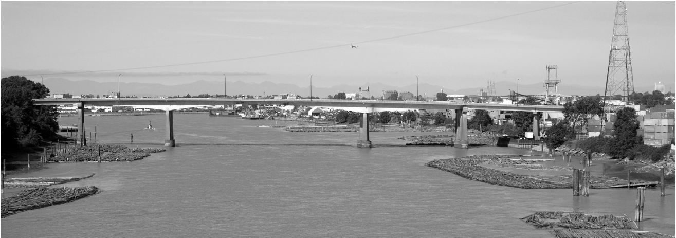
PONT FERROVIAIRE DU CANADIEN NATIONAL (2007)
