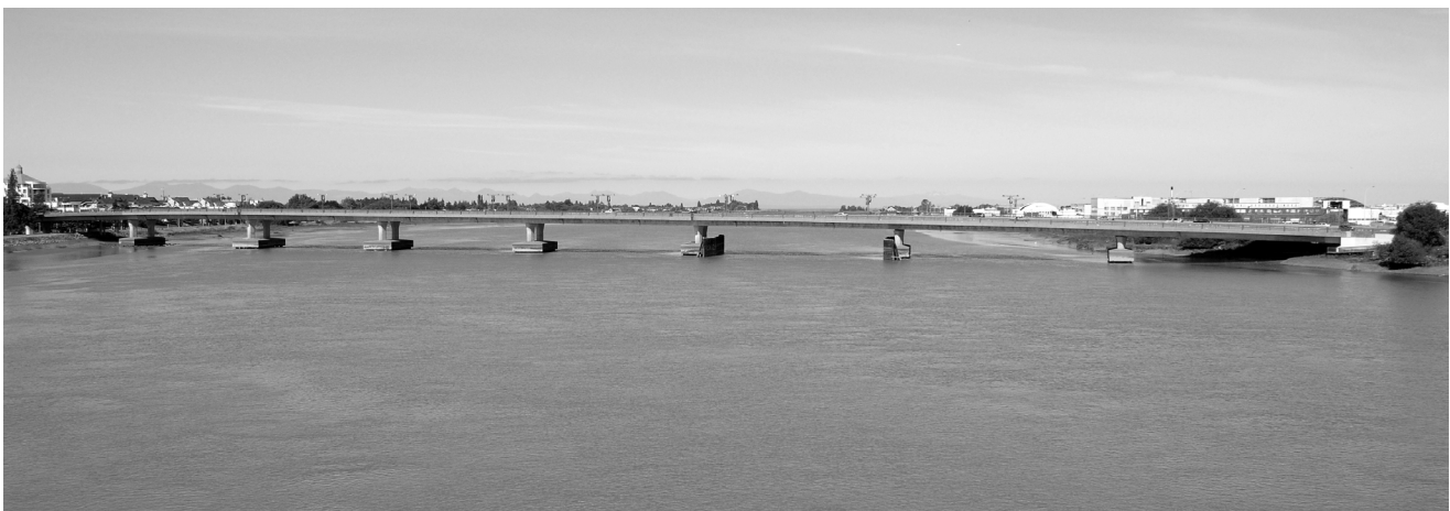
PONT DE LA ROUTE N° 2 (2007)
