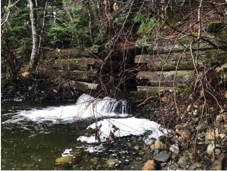
1.) Wolf Creek culvert
