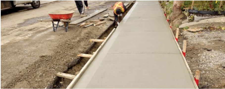
Jalons pour coffrages portant une marque à 29 cm
