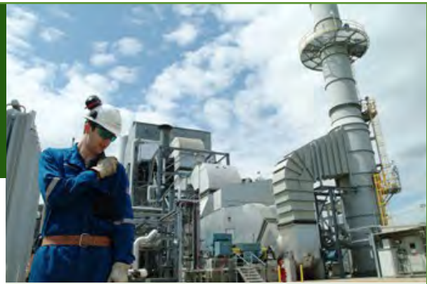
Installation de production d'hydrogène d'Air Products près d'Edmonton, AB.
