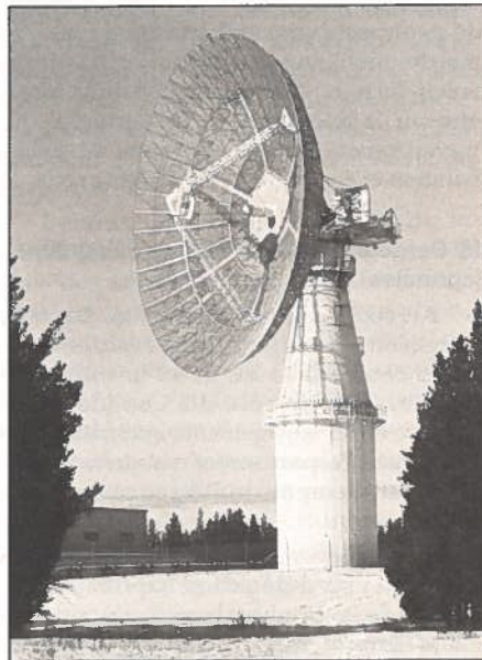
A Prince-Albert (Saskatchewan), cette antenne de 26 mètres capte l'information sur la haute atmosphère transmise par l'Akebono.
