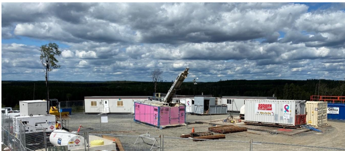
Figure K.7 : Vue aérienne d'un site de forage dans la région de la Nation ojibwée de Wabigoon Lake-Ignace
