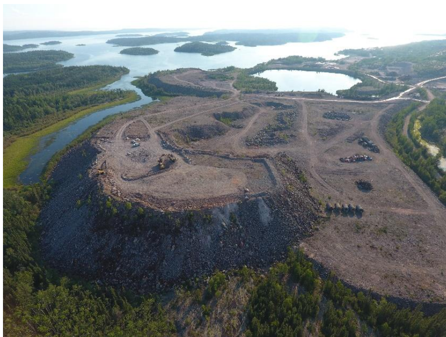
Figure 7.3 : Vue aérienne du site minier de Gunnar (photo prise par le SRC en 2017)
