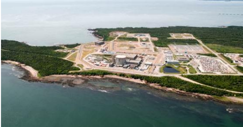
Figure 4.14 : Centrale nucléaire de Point Lepreau
