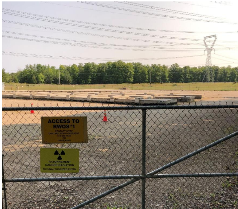
Figure 5.30 : Aire de stockage des déchets radioactifs – site-1
