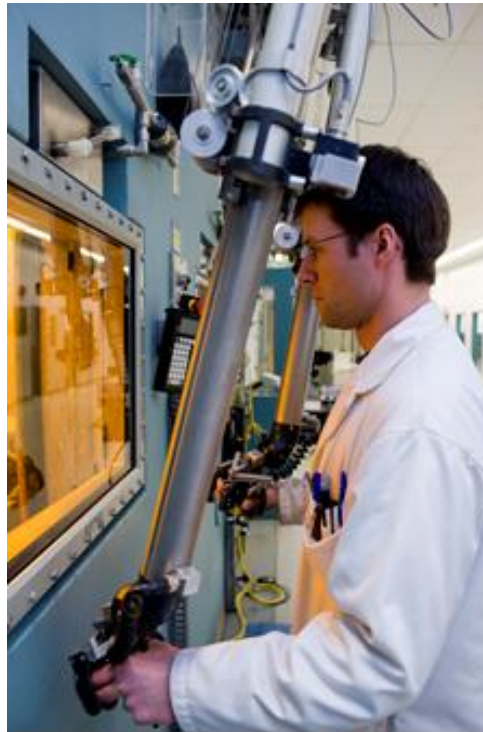
Figure 5.22 : Cellules de haute activité à l'installation de fabrication de Nordion, à Kanata
