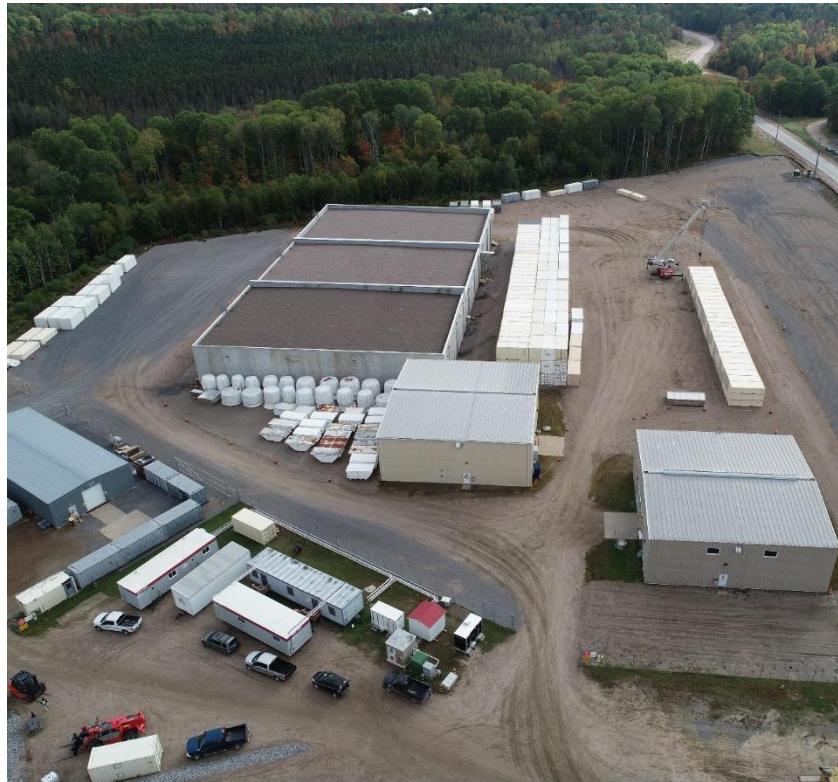
Figure 5.9 : Zone de gestion des déchets H aux LCR
