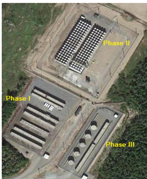
Figure 5.24 : Installation de gestion des déchets de Point Lepreau
