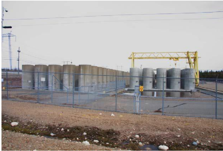
Figure 4.15 : Installation de gestion des déchets radioactifs solides de Point Lepreau
