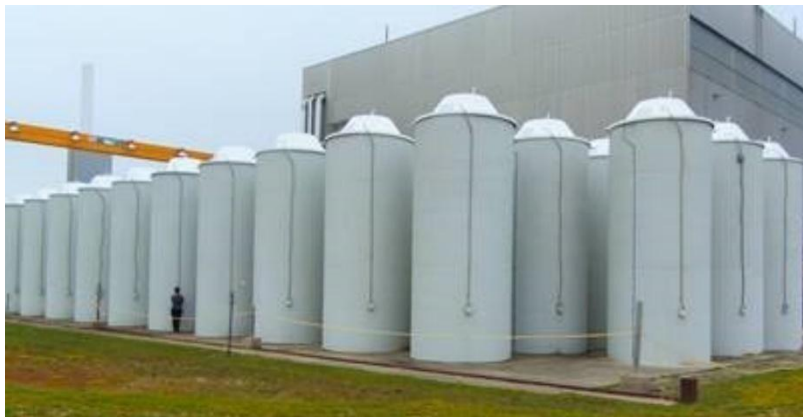
Figure B.2 : Silos de béton d'EACL à Douglas Point
