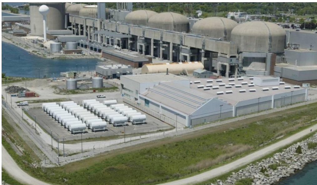
Figure 5.23 : IGD de Pickering, dont l'aire de stockage des composants de retubage (à gauche) et la zone de stockage à sec du combustible utilisé (à droite)
