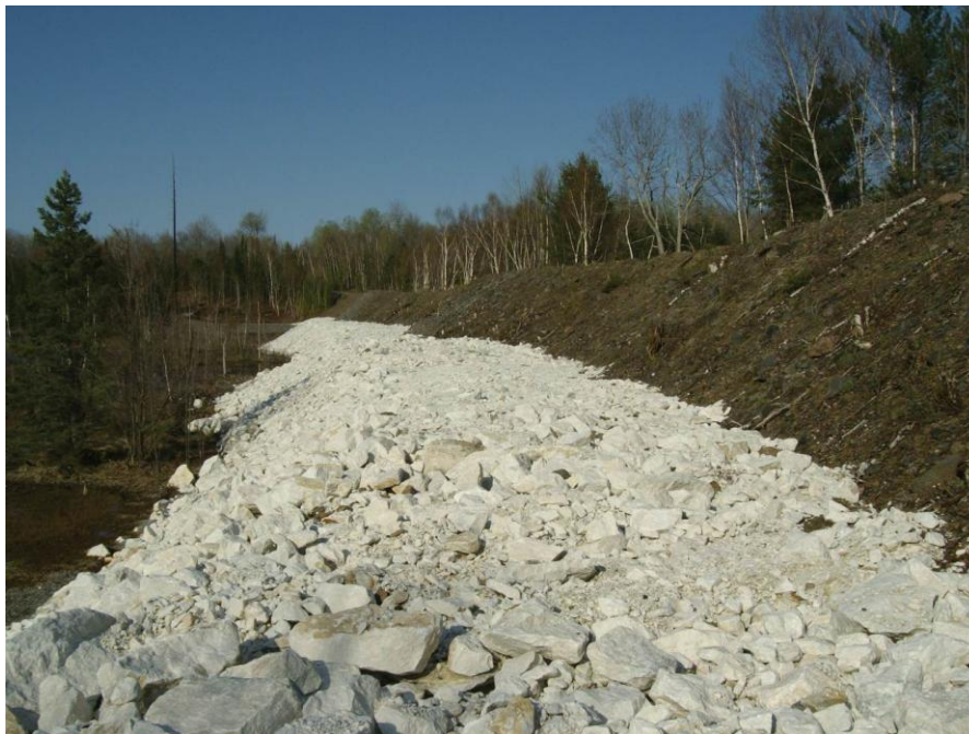
Figure 7.18 : Barrage principal de résidus du site minier Dyno
