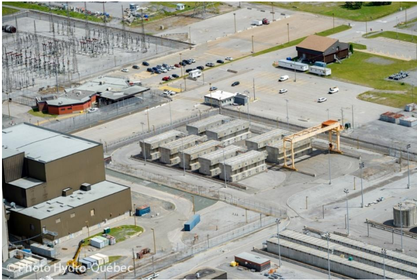
Figure 4.10 : Installation de stockage à sec du combustible usé de Gentilly-2
