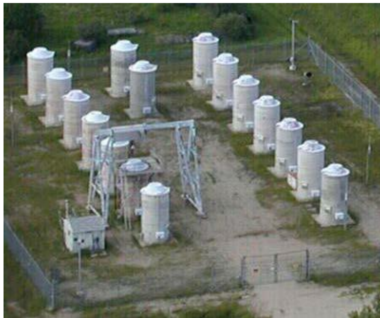
Figure 4.17 : Installation de stockage en silos de béton des Laboratoires de Whiteshell
