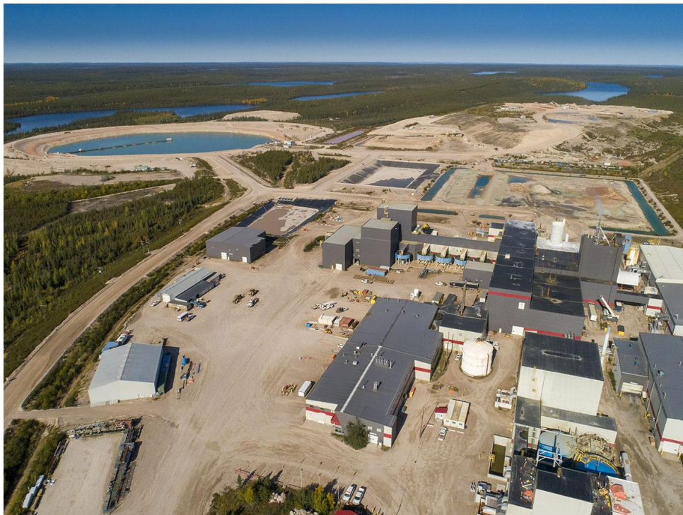
Figure 6.4 : Établissement de McClean Lake; l'IGR JEB est située à gauche de l'usine de concentration
