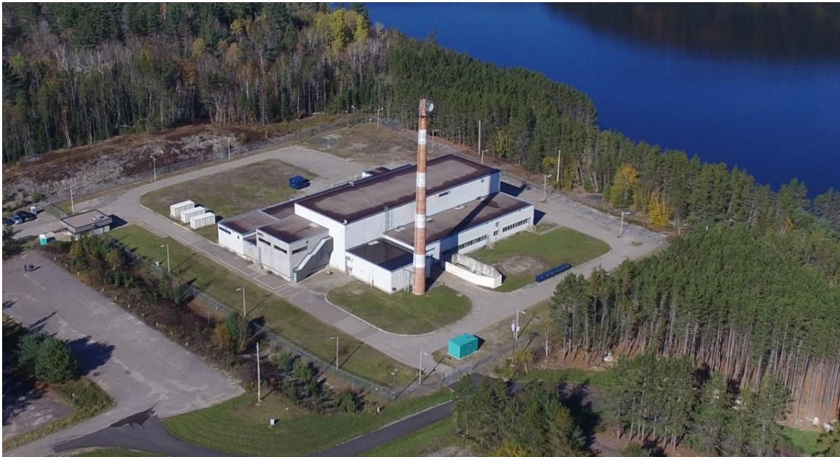
Figure 5.29 : Réacteur nucléaire de démonstration
