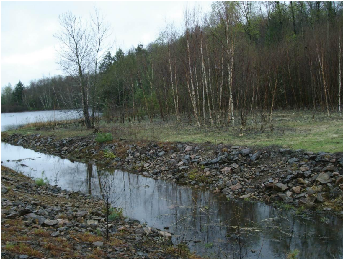
Figure 7.19 : Déversoir du bassin de résidus sud de l'installation de stockage de résidus Bicroft
