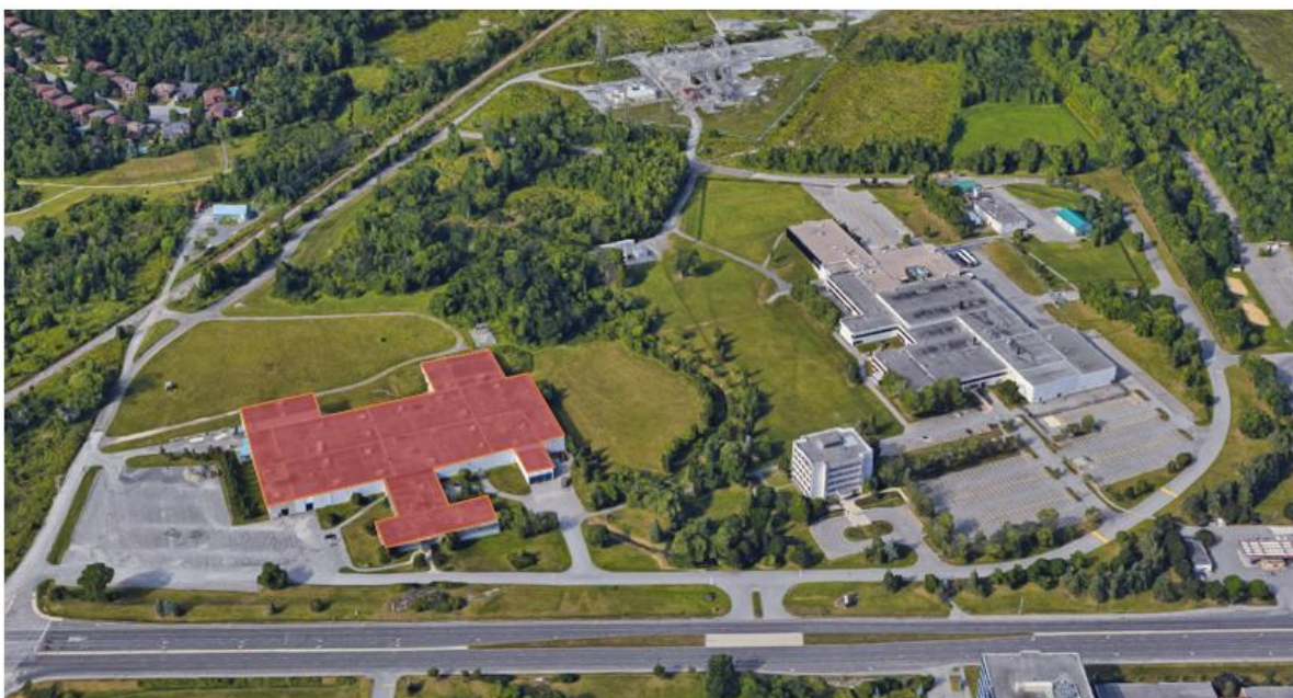
Figure 5.12 : Installation de fabrication de Best Theratronics à Kanata
