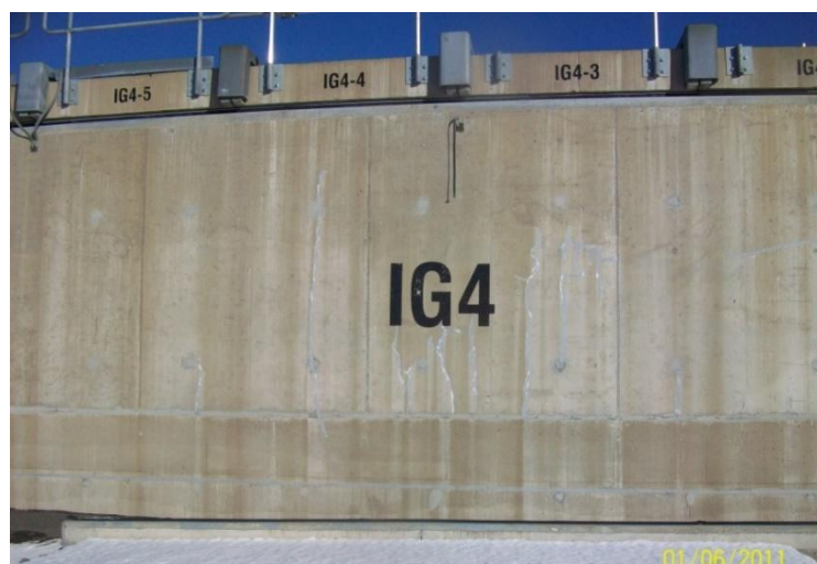
Figure 5.25 : Voûtes d'entreposage de Point Lepreau
