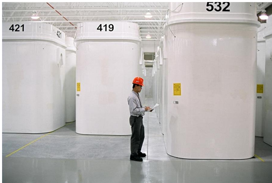
Figure B.5 : Conteneurs de stockage à sec à une IGD d'OPG
