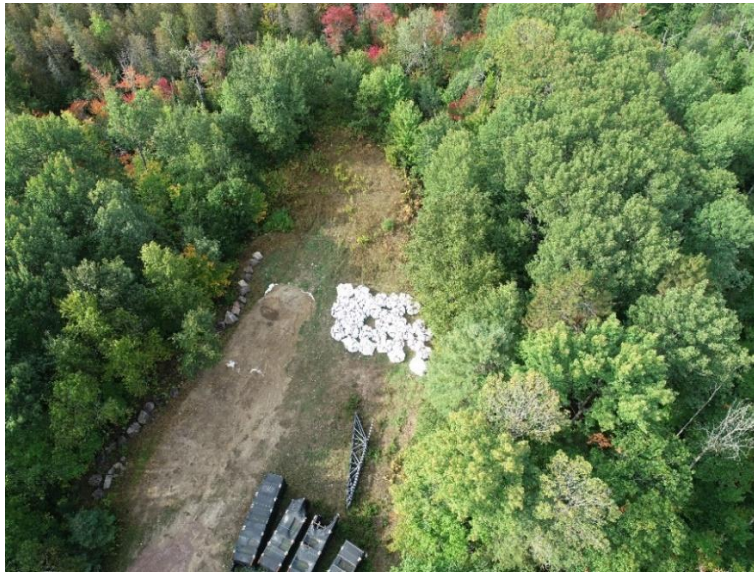
Figure 5.6 : Zone de gestion des déchets E aux LCR
