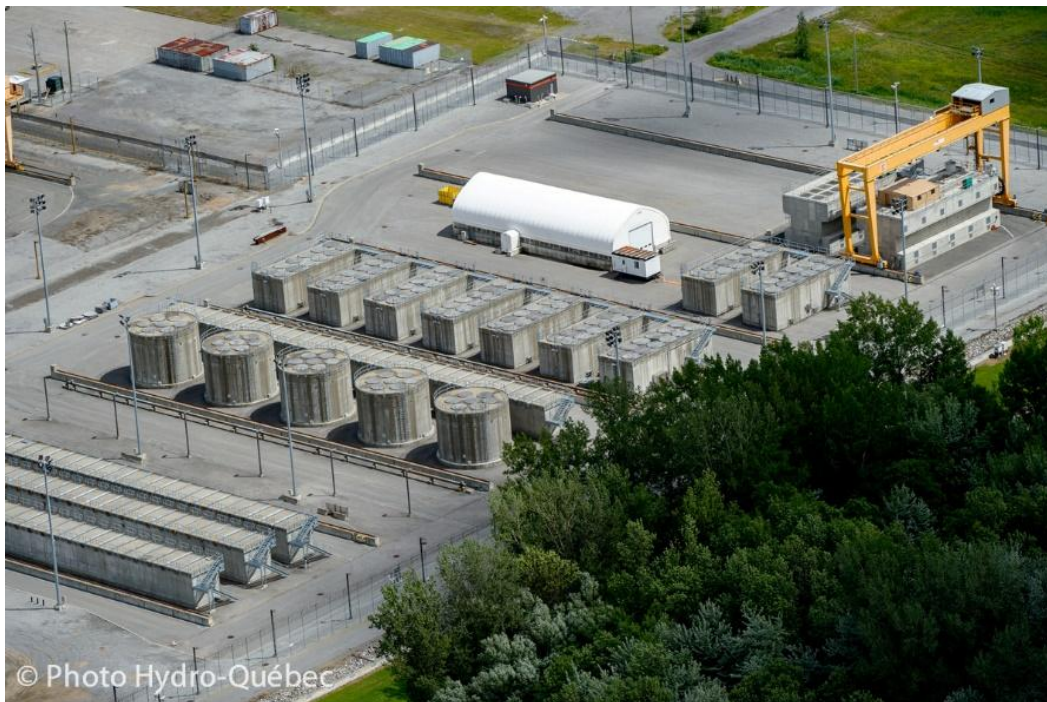
Figure 5.21 : Installation de gestion des déchets de Gentilly-2
