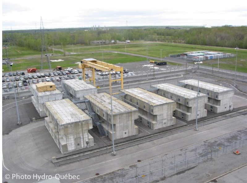
Figure B.3 : Module MACSTOR-200 à Gentilly-2
