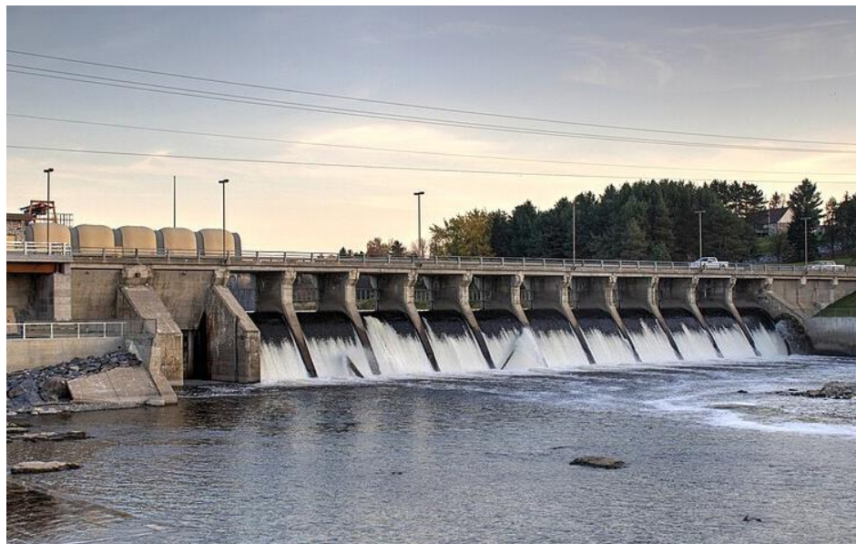
Figure 10 : L'ouvrage de Sartignan au Québec. ( Source )
