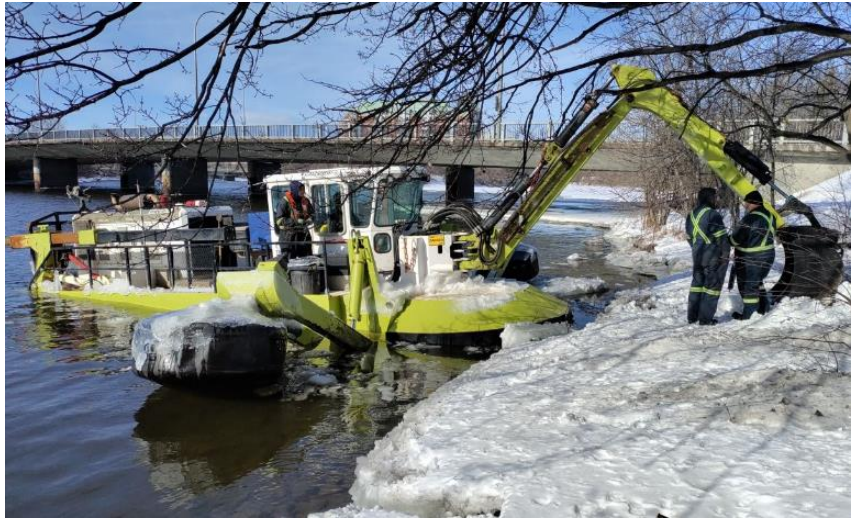
Figure 18 : Un Amphibex sur les berges de la rivière Rideau à Ottawa. (Photo : CNRC)
