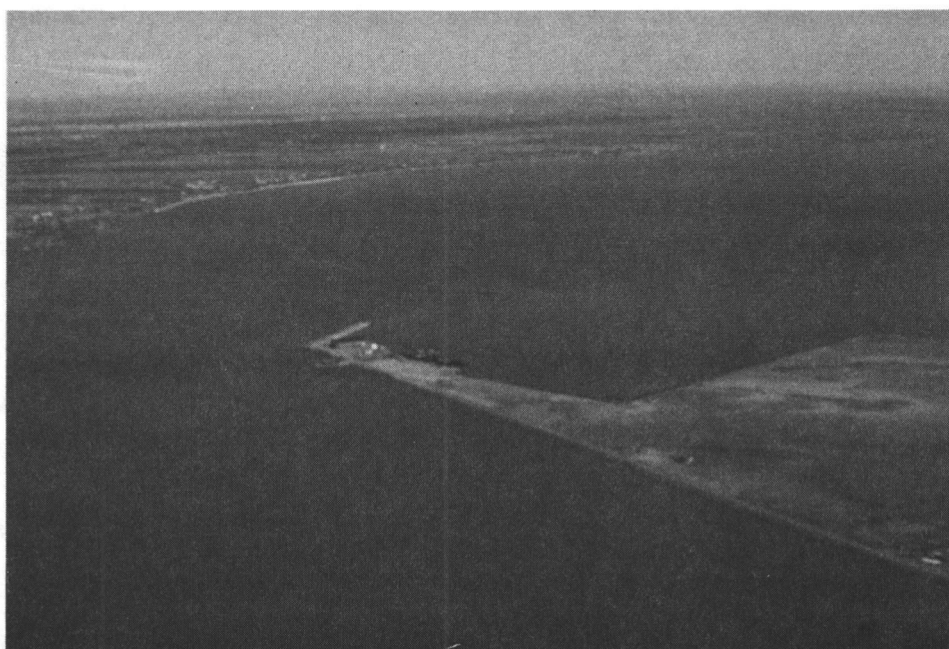
Photos: 7 Vue générale du quai de bécancour
