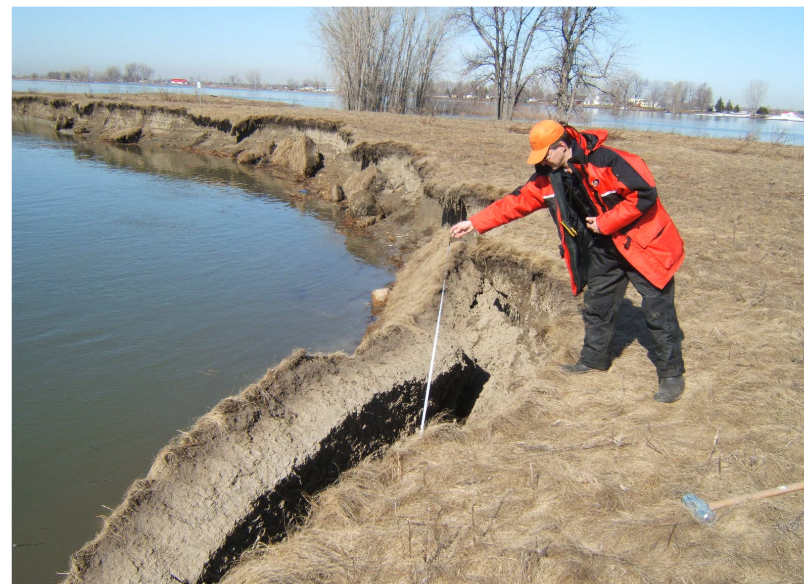
Photo 5 Effondrement des sols en surface à la suite de la gélifraction des parois argileuses
