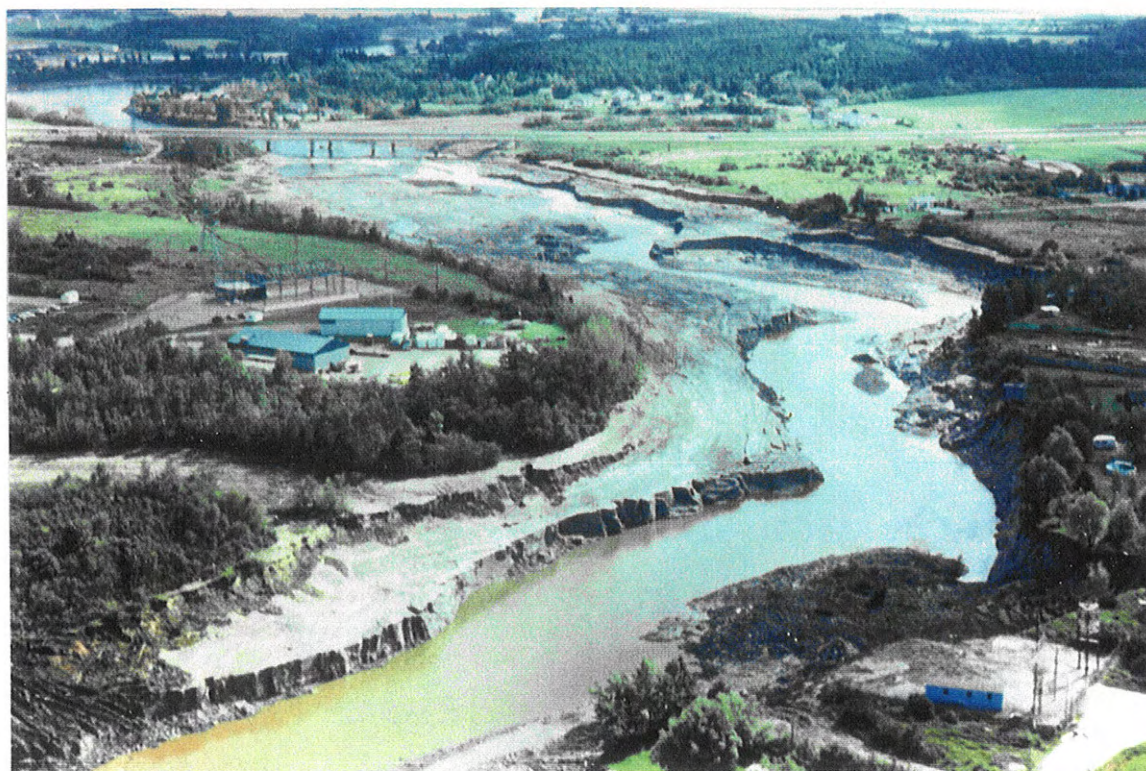
PHOTO #5: Rivière Chicoutimi - Bief d'amont du barrage Pont-Arnaud
