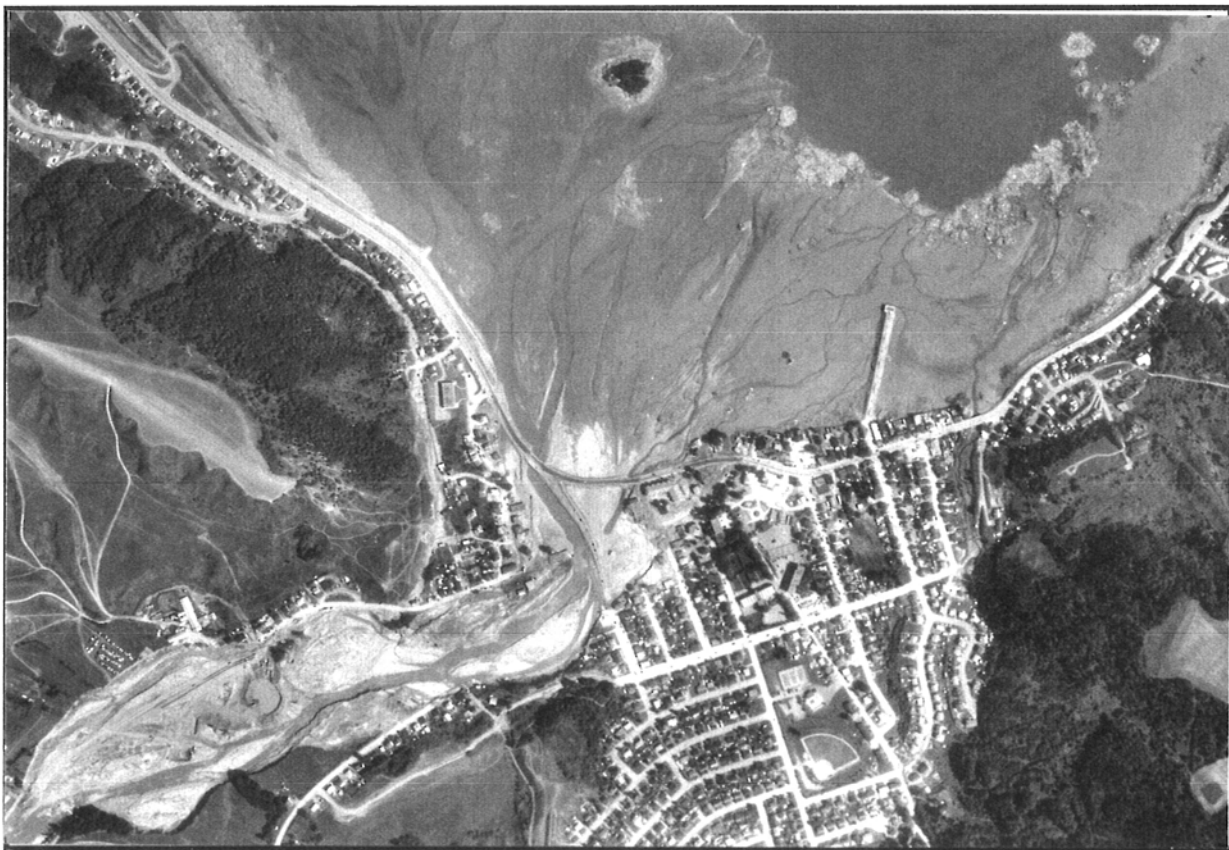
PHOTO #19: Accumulation de sédiments dans la Baie des Ha! Ha! à la suite de la crue de juillet 96 (Photo aérienne Q 96304 #54, échelle 1:15000)
