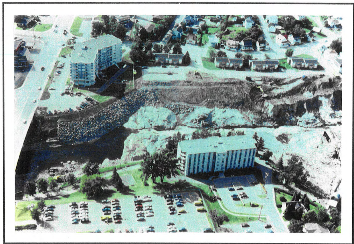
PHOTO #2: Rivière aux Sables. Travaux de stabilisation dans le secteur des HLM à Jonquière (Environnement Canada, Denis Lehoux, 26 août 1996)
