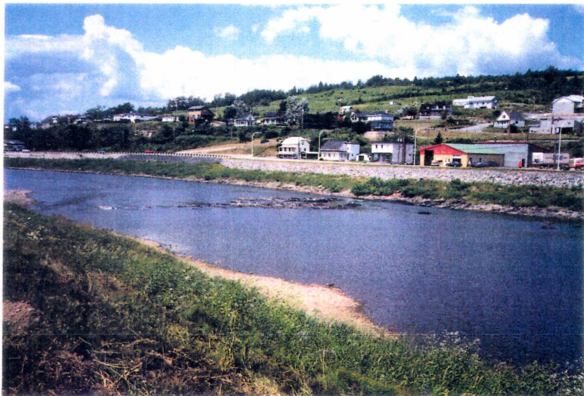
Vue de la rivière au km 61,0. L'éperon rocheux marquent la limite amont d'un tronçon où le niveau naturel du fond de la rivière est élevé. Les vitesses y sont plus fortes. Les embâcles ne sont pas stables à cet endroit et descendent au km 58,5.
