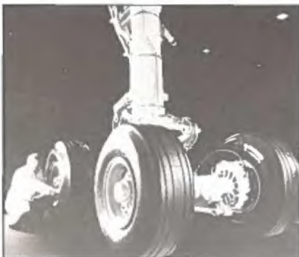
Colin Knight apporte les ajustements finaux au plus gros train d'atterrissage jamais fabriqué pour un avion civil : 4,72 m (15 pi 6 po).
