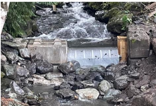
Figure 2. Configuration finale de la prise d'eau, vue vers l'amont
