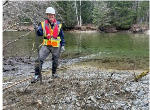
Figure 1. Pousses de saule vivantes plantées sur la berge droite, à la confluence du ruisseau Green et de la rivière Nanaimo (photo prise le 7 mars 2025).
