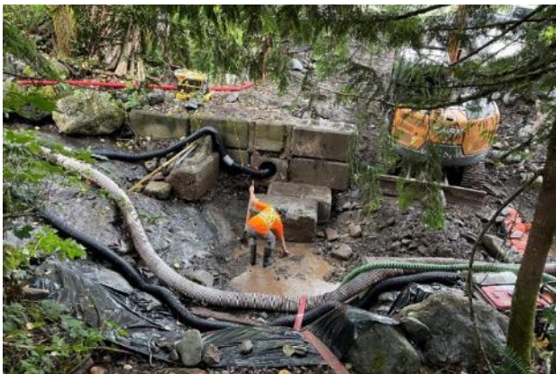
Figure 1. Préparation de la fondation de la prise d'eau, vue vers l'amont
