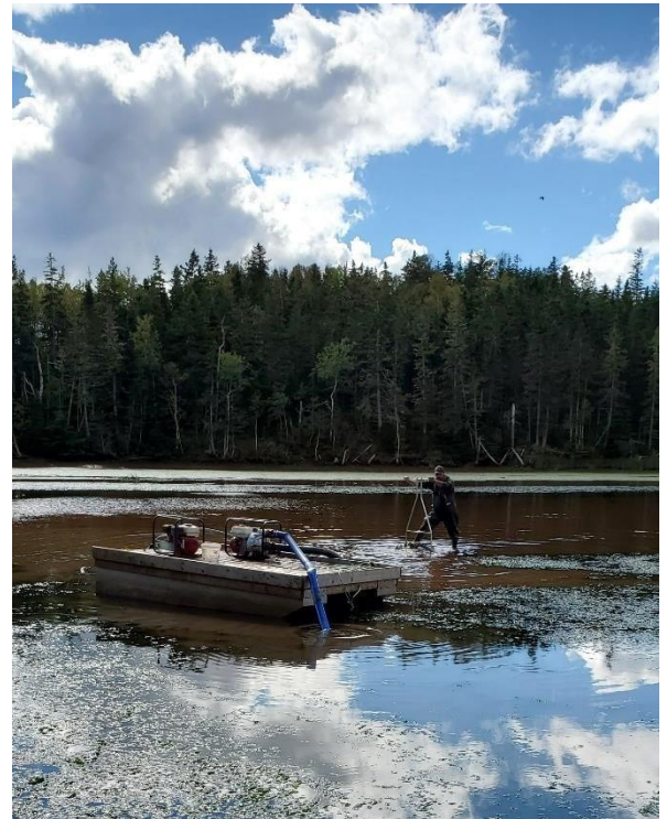
Figure 5 : Un ancien superviseur sur le terrain de Souris wildlife utilise le silt gator, pour aspirer le limon du lit de la rivière et le redistribuer sur le paillasonnage en branches afin d'étendre le marais salé (© PEI Watershed Alliance)
