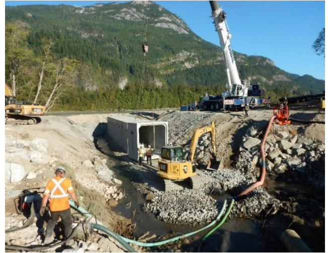
Figure 6 : Remplacement d'un ponceau par un ponceau à dalot en béton (© Squamish River Watershed Society)
