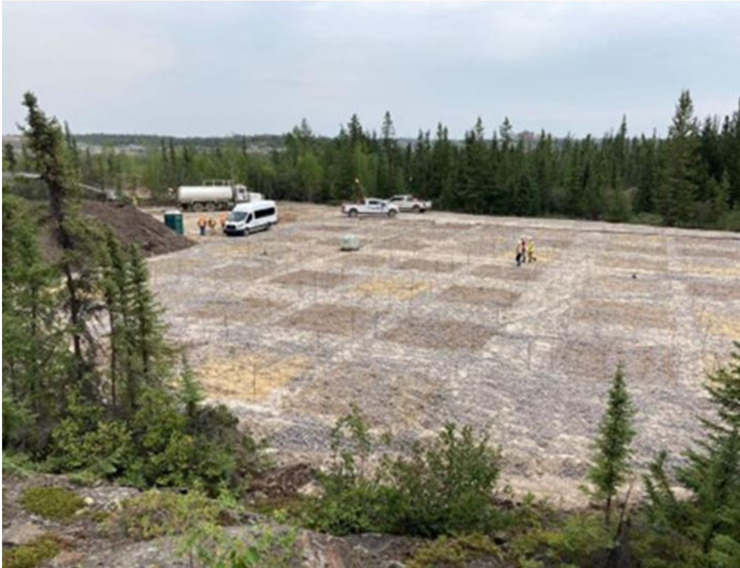
Parcelles d'essai de végétalisation sur le site de la mine Giant.
