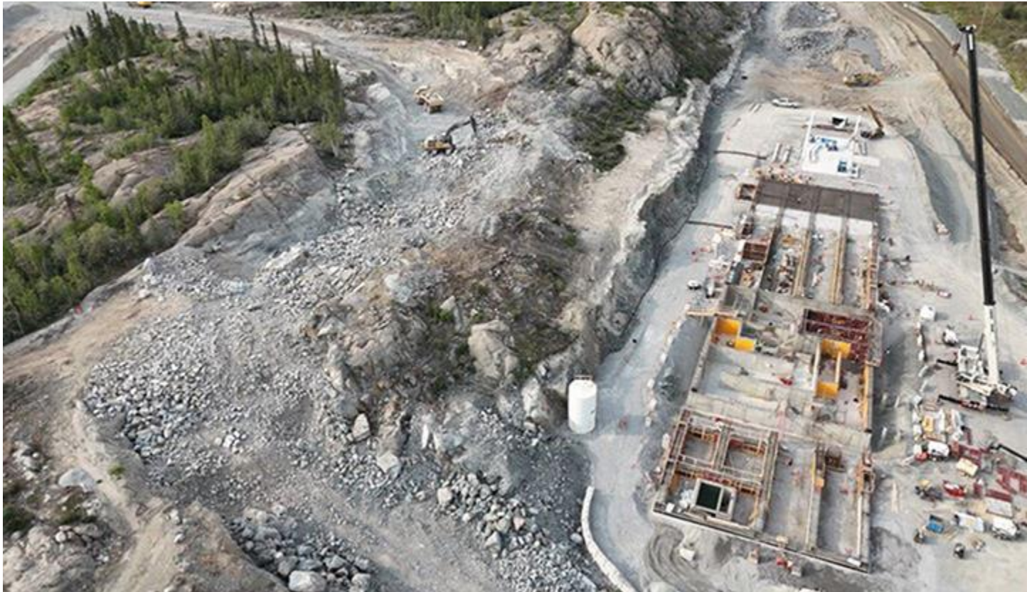
Vue aérienne de la construction de l'usine de traitement de l'eau
