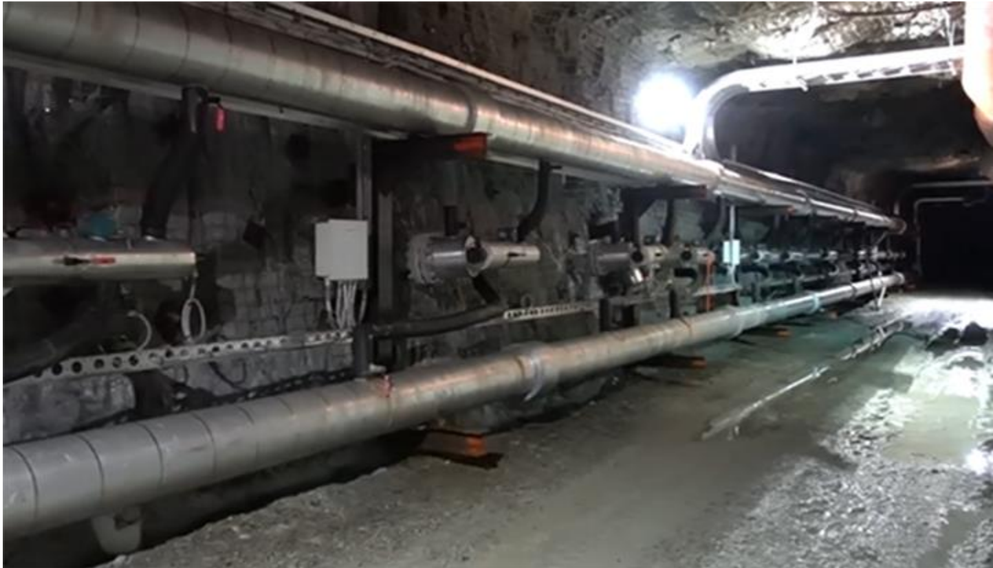
Une chambre de mine souterraine.
