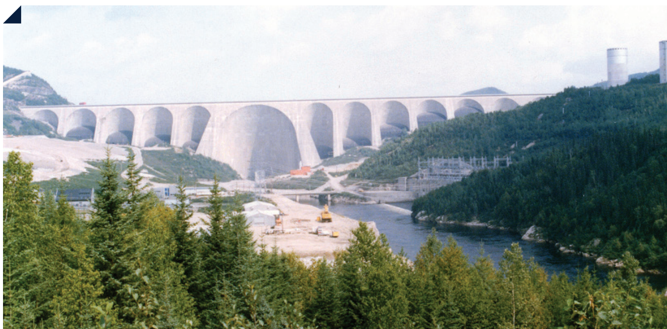
Barrage Daniel-Johnson à Manic-5
