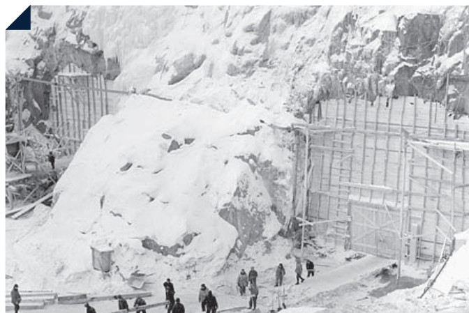
Construction de l'entrée de la galerie C de l'aménagement hydroélectrique de Shipshaw
