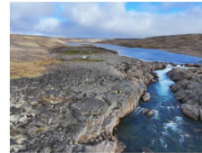
Iqaluit Nukkiksautiit Hydro Project, Iqaluit, Nunavut
