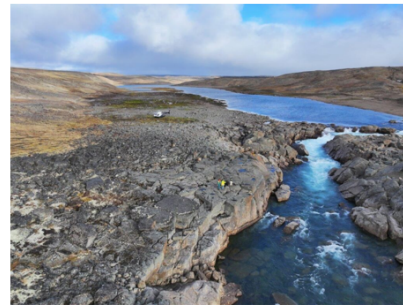
Le Projet hydroélectrique de la Nunavut Nukiksautiit Corporation à Iqaluit — Iqaluit, Nunavut
