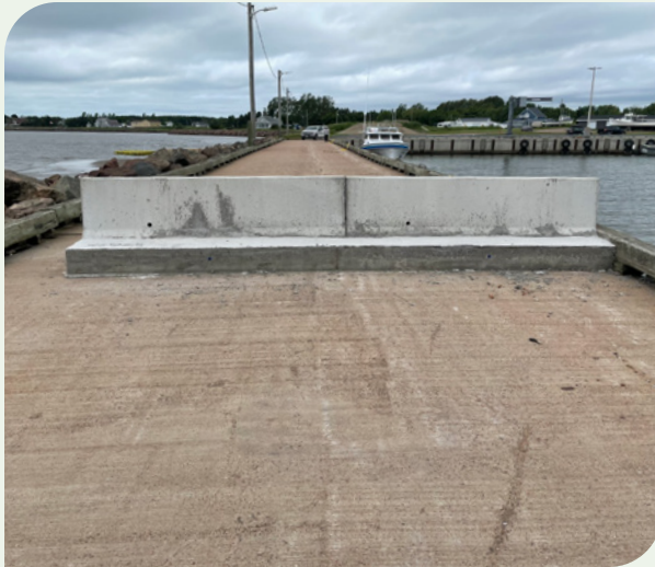
Port pour petits bateaux de Cap-des-Caissie, Nouveau-Brunswick Photo : Pêches et Océans Canada, 2023
