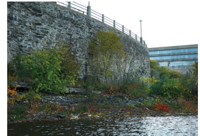
Plus de 600 structures différentes (murs de soutènement, plateformes de belvédère, barrages)
