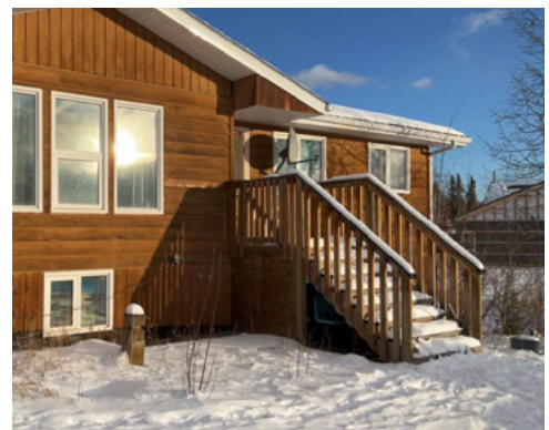
Habitations dont les émissions de GES ont diminué de plus de 80 % grâce à des rénovations très écoénergétiques.
