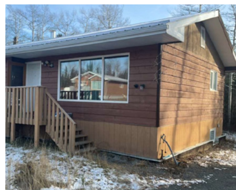
Habitations dont les émissions de GES ont diminué de plus de 80 % grâce à des rénovations très écoénergétiques.
