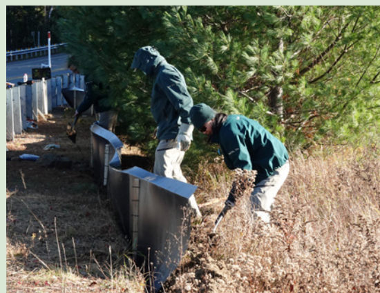
Employés effectuant des travaux d'entretien
